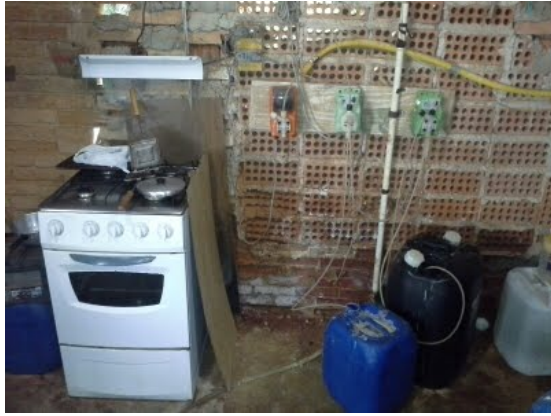
Descrição(5): Bombas dosadoras junto de utensílios de cozinha
