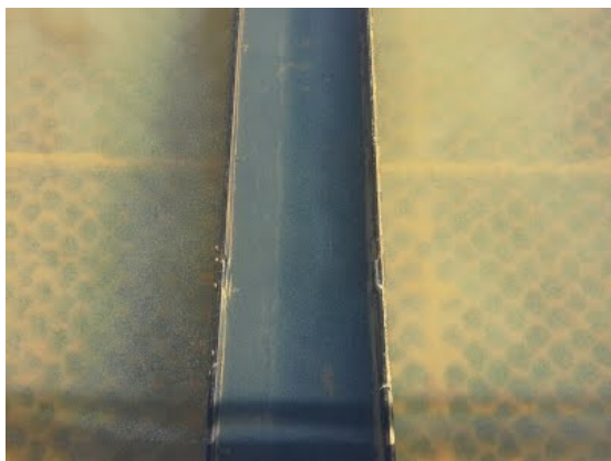
Descrição(5): Passagem de flocos para um dos filtros
