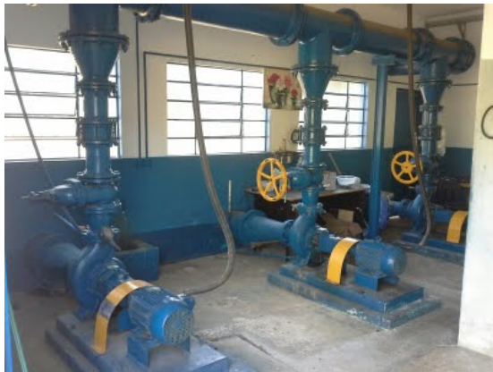
Descrição(5): Bombas aspiradas
