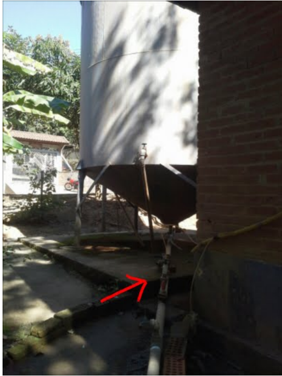
Descrição(1): Chegada do recalque, aplicação de coagulante (ponto indicado) e decantador
