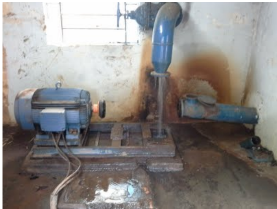
Descrição(5): Conjunto de recalque em manutenção
