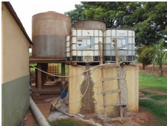
Descrição(8): Armazenamento de produtos químicos
