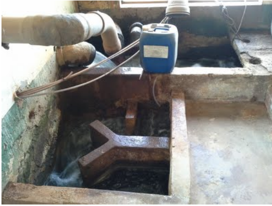
Descrição(5): Mistura rápida e floculador
