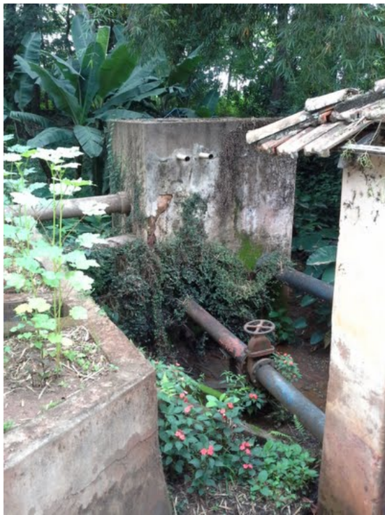
Descrição(3): Poço de sucção
