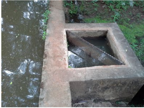
Descrição(2): Tomada de água
