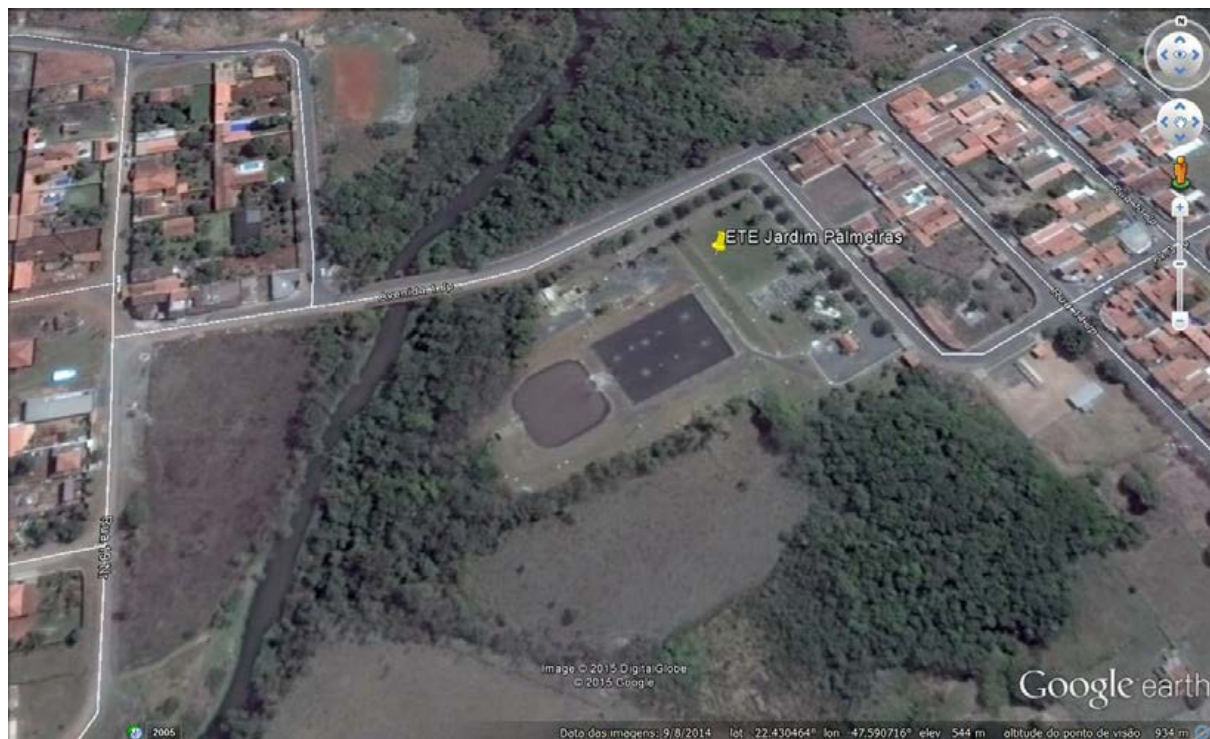
Figura 06 - Imagem de satélite da ETE Jardim Palmeiras
