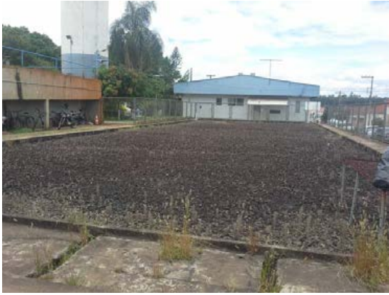
Descrição(1): Reservatório junto ETA
