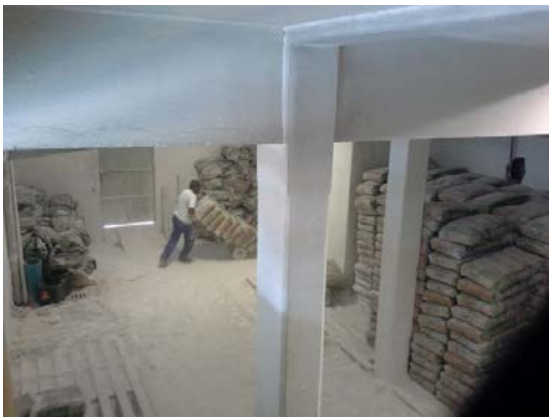
Descrição(10): Armazenamento de cal
