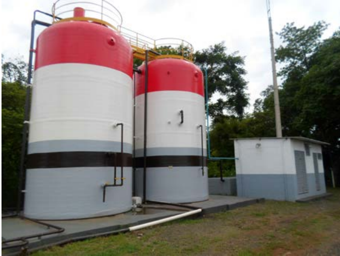
Descrição(2): UASB seguido de Filtro Aerado Submerso
