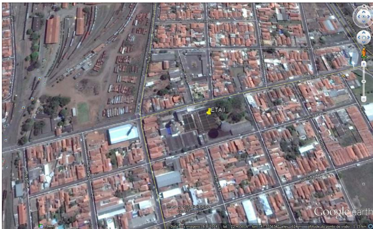
Figura 03- Imagem de satélite da Estação de Tratamento de Água – ETA I
