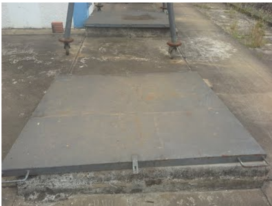
Descrição(2): Detalhe tampas inspeção
