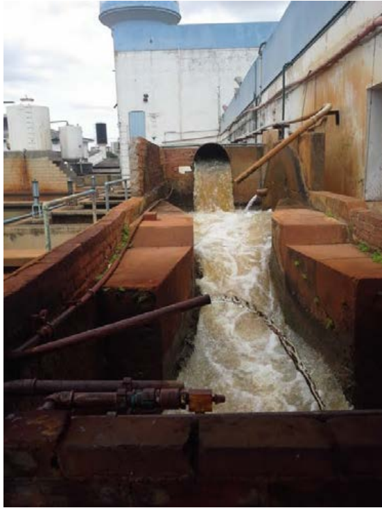
Descrição(1): Chegada água bruta
