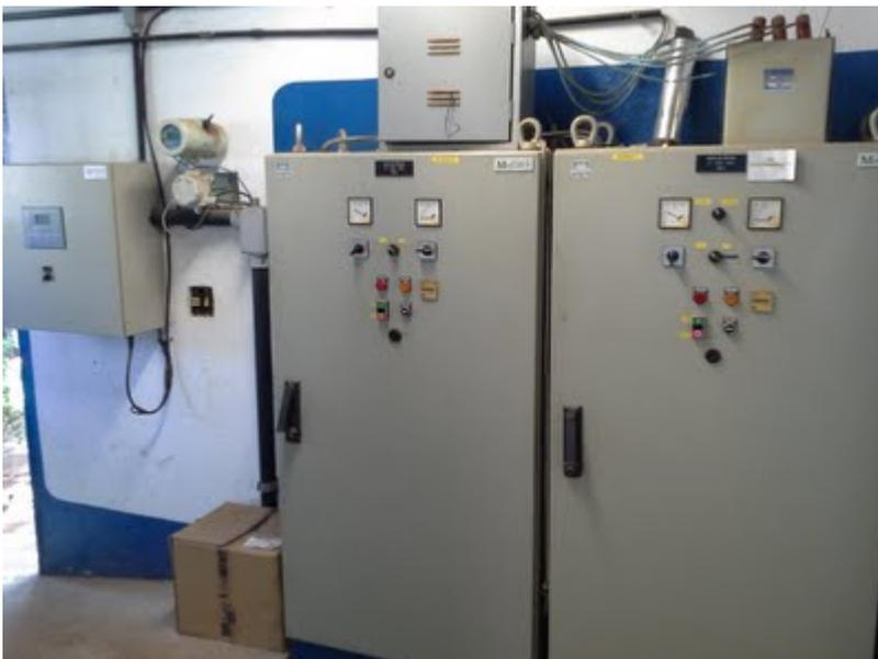
**Descrição(3):** Painel elétrico e medidor de vazao
