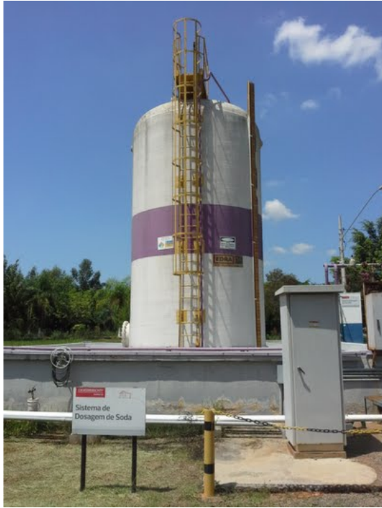
Descrição(3): Armazenamento de produtos químicos (soda)
