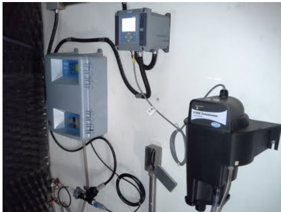
Descrição(5): Monitoramento on line de turbidez e Cloro residual
