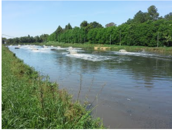
Descrição(6): Lagoa facultativa
