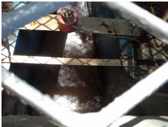
Descrição(7): Medição de vazão do efluente final
