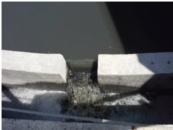
Descrição(6): Efluente do adensador de lodo
