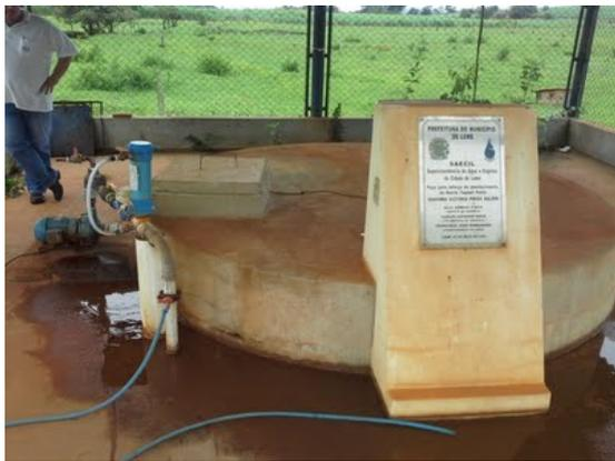
**Descrição(2):** POCO, recalque, cloração e fluoretação
