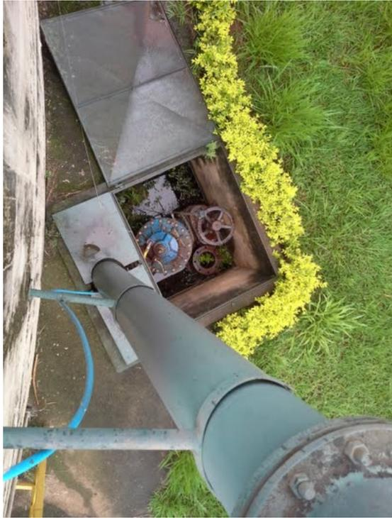
**Descrição(3):** Tubulação de entrada e válvula controladora de nível
