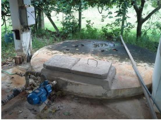
**Descrição(1):** Poço, conjunto de recalque e painel elétrico
