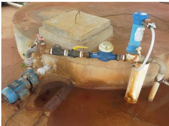
**Descrição(3):** Recalque, hidrômetro, cloração e fluoretação
