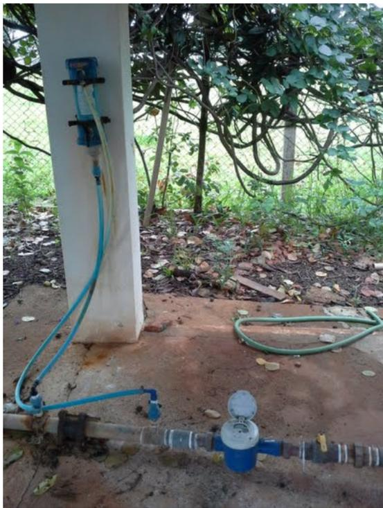
**Descrição(2):** Hidrômetro e clorador/fluoretador
