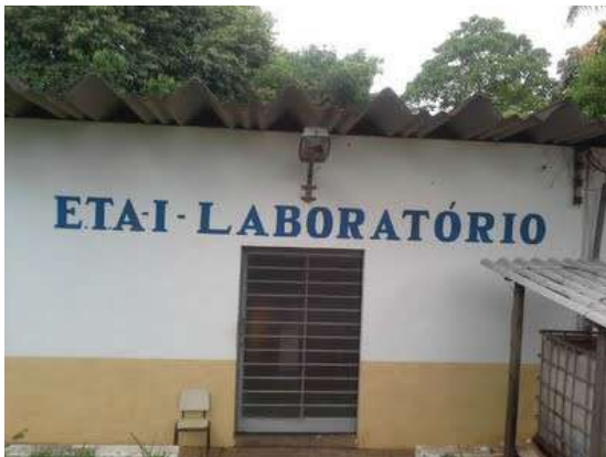
Descrição(6): Identificação da ETA 1
