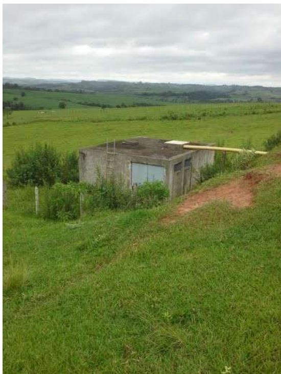
Descrição(4): Vista Geral - EEEB Centro
