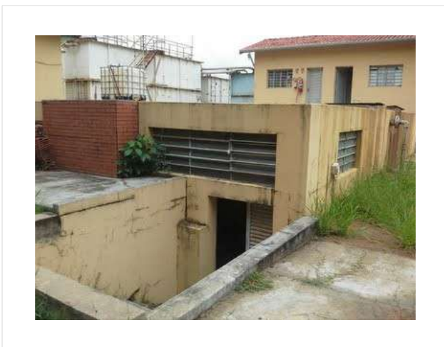
Descrição(15): Vista Geral da EEAT - Portal dos Nobres
