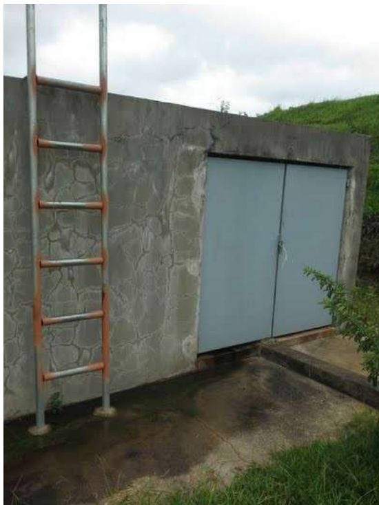
Descrição(3): Escada de Acesso e Entrada da Casa de Bomba - EEEB Centro
