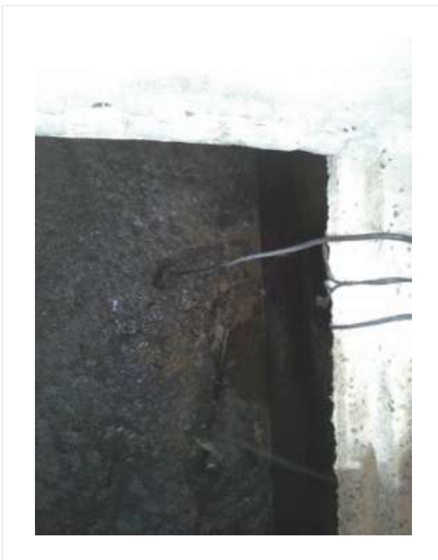
Descrição(2): Tampa de Inspeção de Acesso ao Tanque Receptor de Esgoto - EEEB Centro
