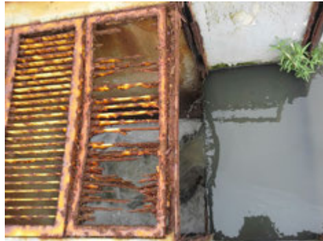
Descrição(16): Situação precária das grades de piso sobre os vertedores de saída do esgoto tratado da lagoa facultativa
