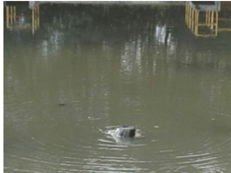
Descrição(12): Entrada do esgoto na lagoa facultativa vindo da lagoa aerada
