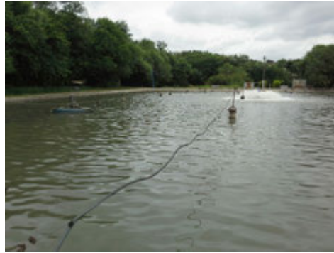
Descrição(11): Vista geral da lagoa aerada com poucos aerações superficiais em funcionamento
