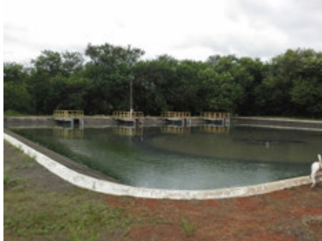
Descrição(8): Vista geral da lagoa com revestimento em concreto e ao fundo os vertedores de saída do esgoto tratado da lagoa facultativa
