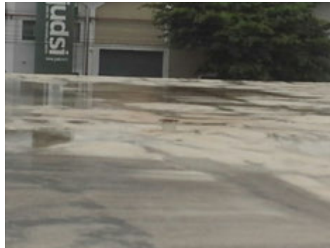
Descrição(9): Laje de cobertura de um dos Reservatórios Semienterrados Imagem(10)
