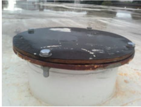
Descrição(8): Detalhe da tampa de inspeção de um dos Reservatórios Semienterrados Imagem(9)
