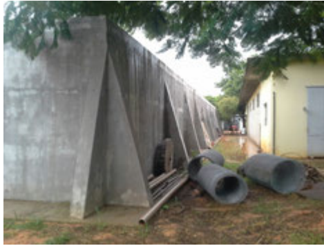
Descrição(4): Reservatório Semienterrado 2 - 1000 m3
