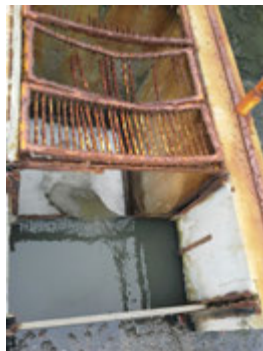
Descrição(16): Situação precária das grades de piso sobre os vertedores de saída do esgoto tratado da lagoa facultativa
