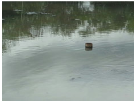
Descrição(13): Outro ponto de tubulação de entrada do esgoto bruto na lagoa facultativa vinda da lagoa de aeração
