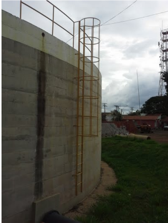
Descrição(3): Guarda corpo escada acesso
