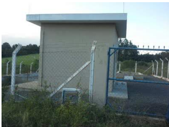
Descrição(6): Vista geral da elevatória
