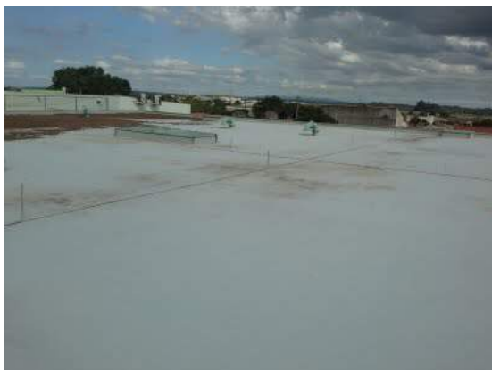
Descrição(4): Vista geral superior do reservatório
