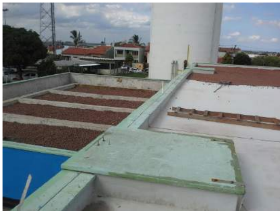
Descrição(3): Vista superior do reservatório
