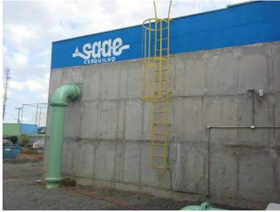
Descrição(2): Vista geral do reservatório
