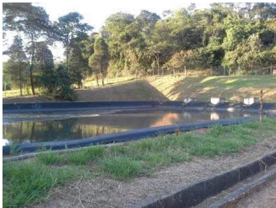
Descrição(5): Vista geral da lagoa anaeróbia
