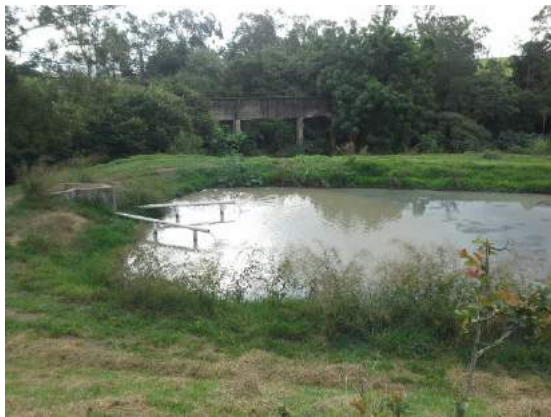
Descrição(3): Vista geral de uma das lagoas facultativas da estação
