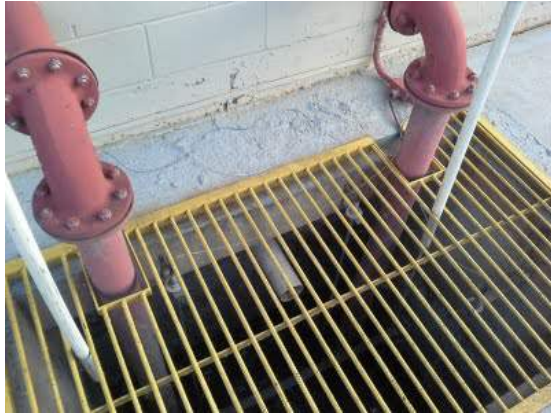
Descrição(4): Vista geral do poço de sucção da elevatória
