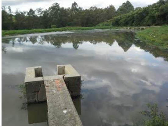
Descrição(2): Vista geral da lagoa anaeróbia da estação
