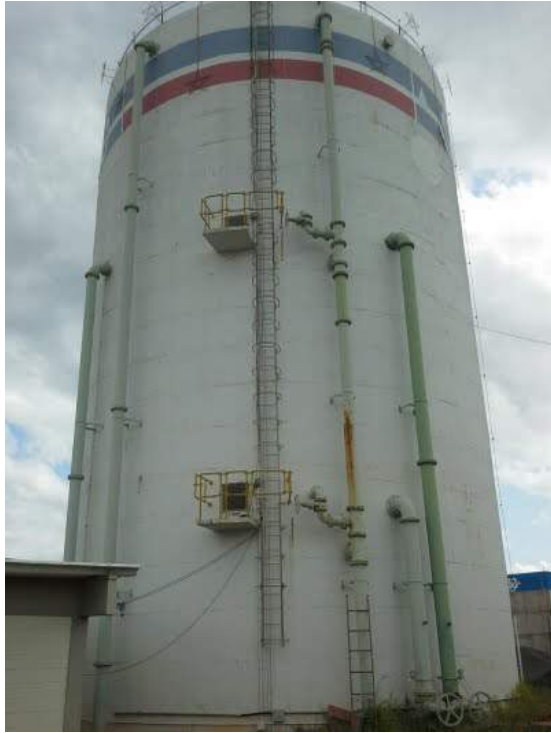
Descrição(2): Vista geral do reservatório
