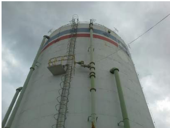
Descrição(3): Vista do detalhamento do reservatório
