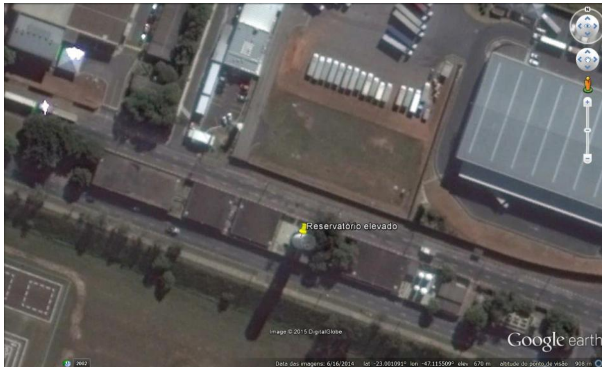
Figura 6 - Imagem de satélite do Centro de Reservação e Distribuição (CRD) - Reservatório Elevado
