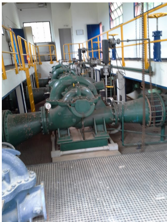
Casa de bombas
