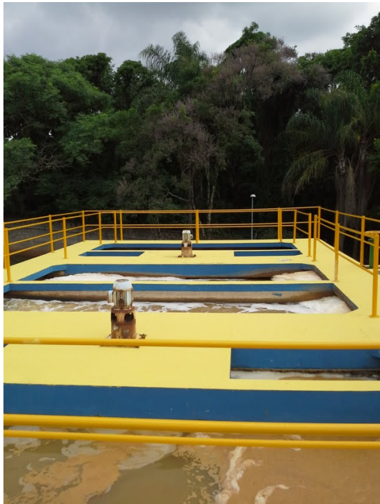
Descrição(2): Tanque de contato
