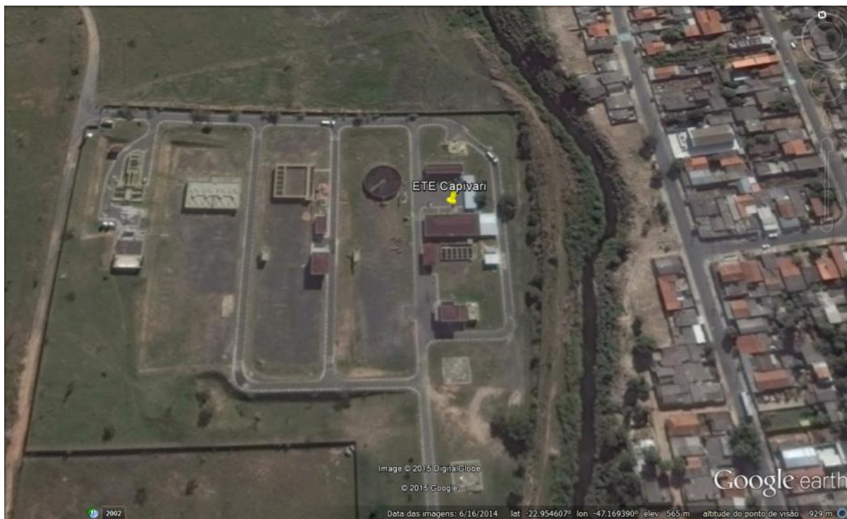
Figura 7 - Imagem de satélite da ETE Capivari
