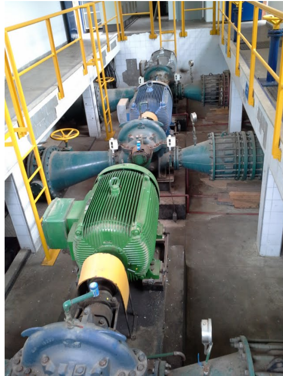
Casa de bombas
