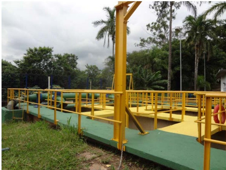
Vista geral da captação Capivari
