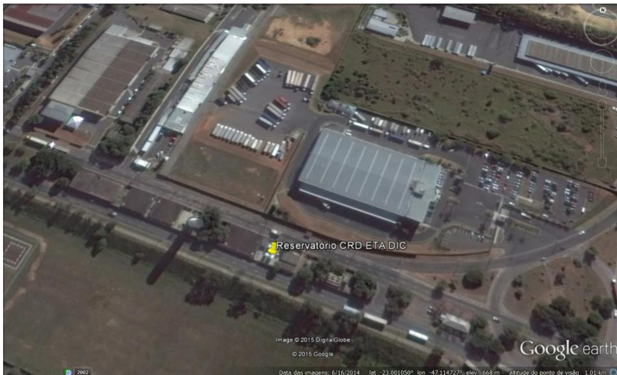
Figura 5 - Imagem de satélite do Centro de Reservação e Distribuição (CRD) – Reservatórios semi-enterrado
