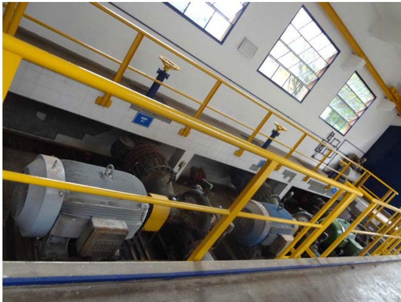
Casa de bombas
