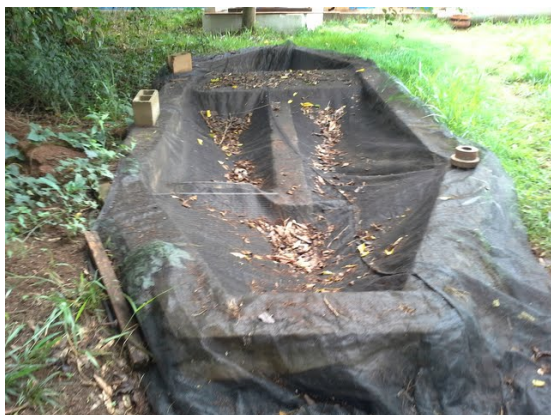
Descrição(4): Detalhe proteção desarenador
