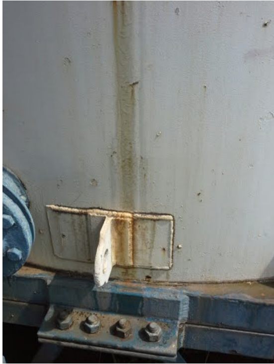
Descrição(2): Vazamentos
