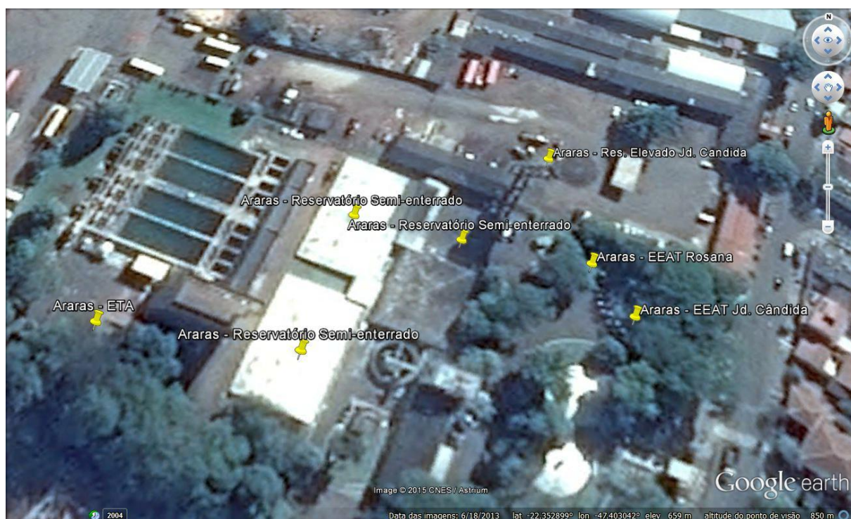
Figura 2 - Imagem de satélite dos reservatórios semi-enterrados junto à ETA
