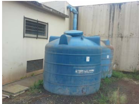
Descrição(2): Armazenamento de produtos químicos
