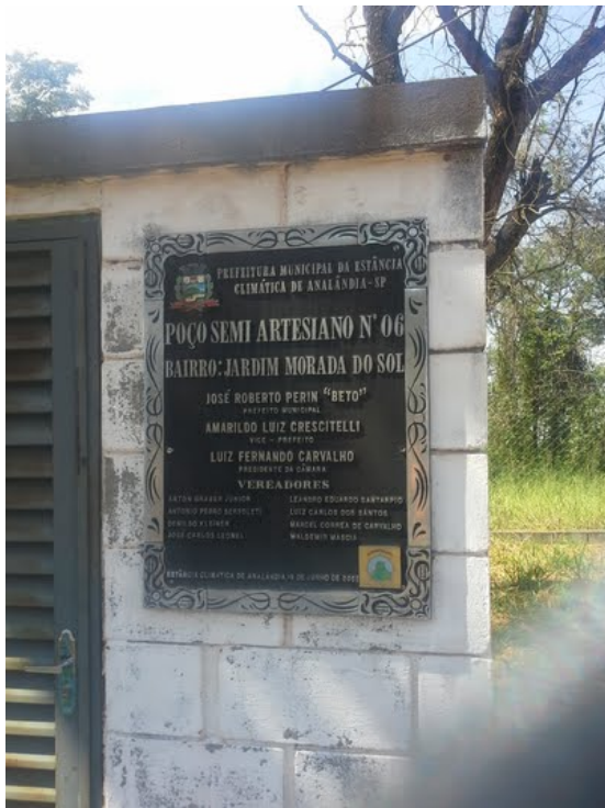
Descrição(2): Identificação poço 6
