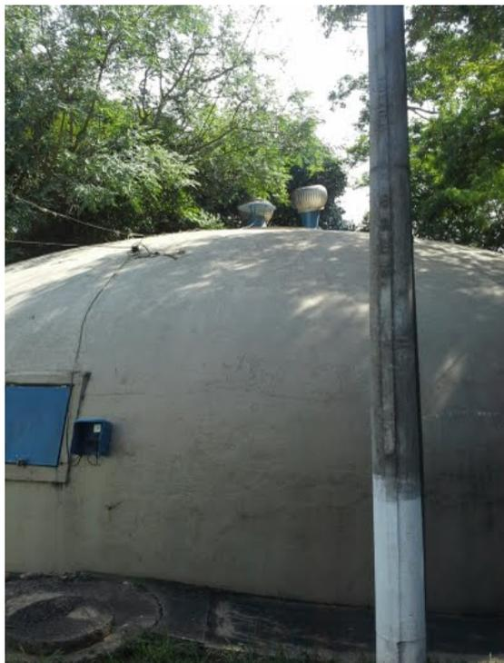
**Ventilação no topo do reservatório**
