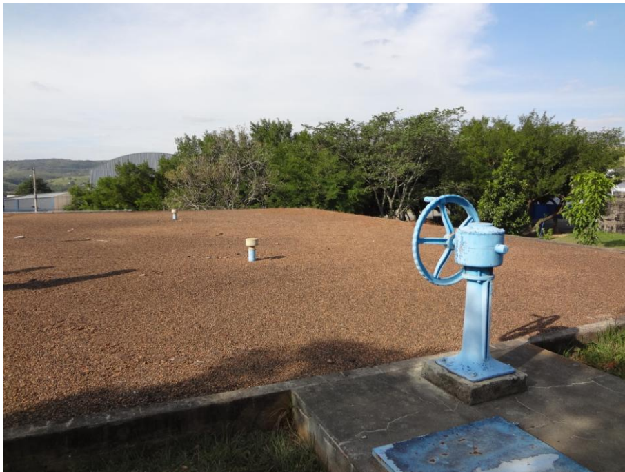
Figura 5 – Reservatório junto a ETA 2
