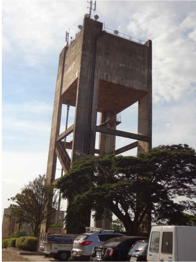
Figura 4 – Reservatório junto a ETA 2
