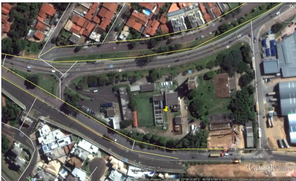
Figura 3 – Estação de Tratamento de água ETA 2
