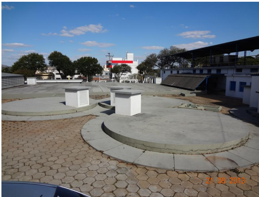
Figura 6 – Reservatório Junto a ETA 1
