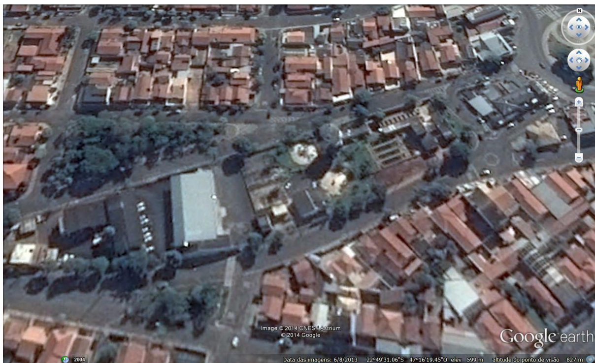
Figura 10 - Imagem de satélite dos reservatórios da ETA I
