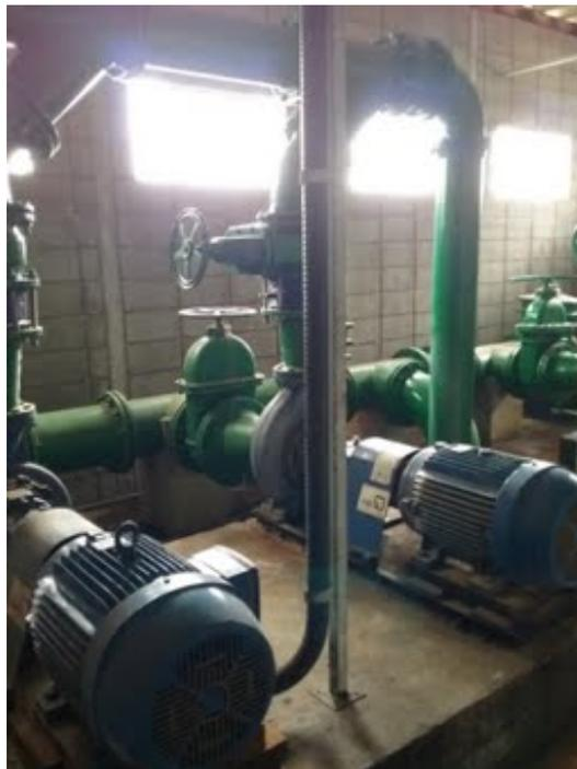
**Descrição(1):** Essas 2 bombas recalcam do reservatório apoiado para elevado. Uma é reserva.
