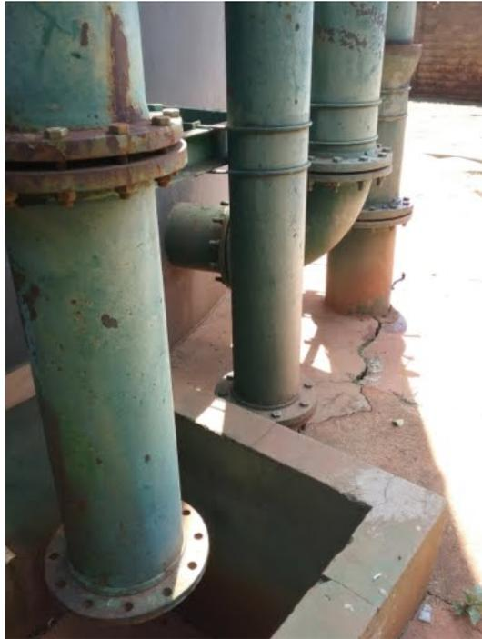
**Descrição(8):** Detalhe das tubulações de entrada/ saída e extravasamento
