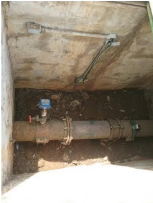
**Descrição(7):** Detalhe do medidor de vazão do poço
