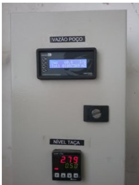
**Descrição(8):** Painéis elétricos - Medidor de vazão
