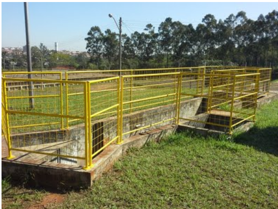
Descrição(4): Guarda-corpo da Calha Parshall, também substituído
