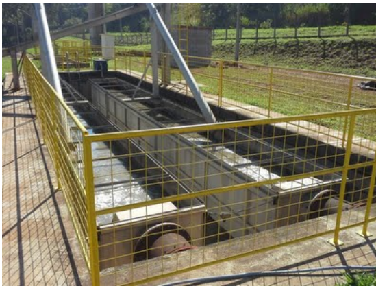
Descrição(3): Guarda-corpo do desarenador, que foi substituído
