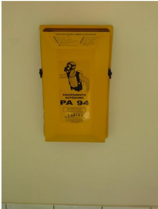
**Descrição(8):** Equipamento autônomo para vazamento de Cloro
