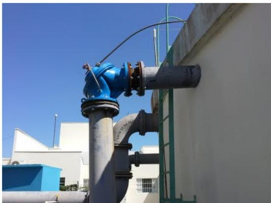
**Descrição(2):** Válvula de nível na entrada do reservatório apoiado
