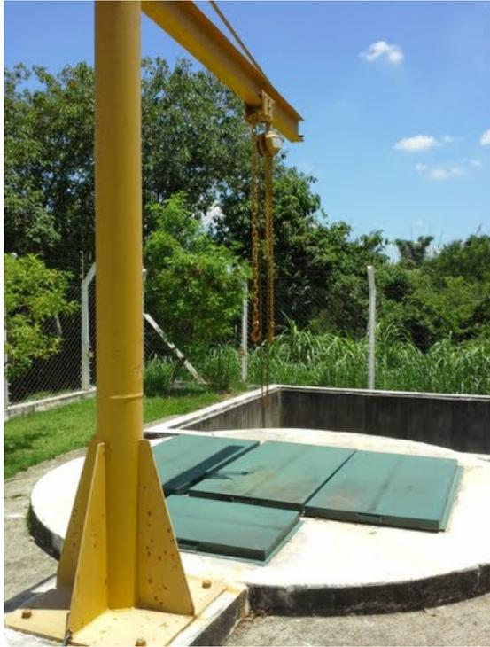
**Descrição(2):** Gradeamento grosseiro e poço de sucção
