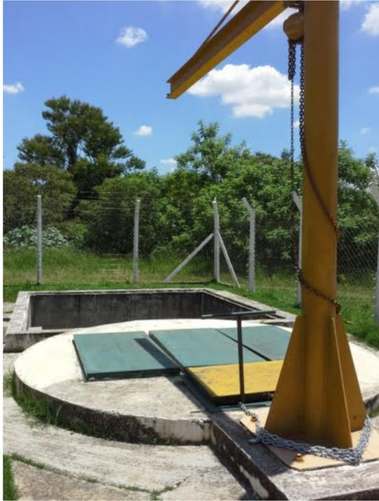
**Descrição(2):** Gradeamento grosseiro e poço de sucção
