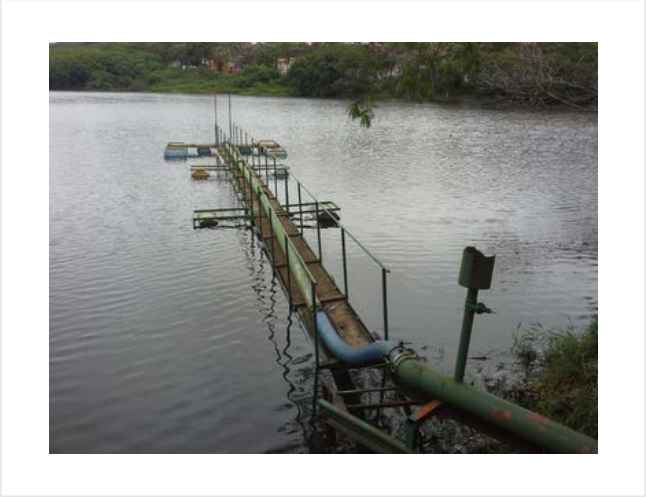
Descrição(3): Tomada de água
