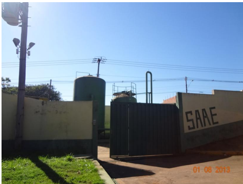
Figura 3 – Fachada da ETA III
