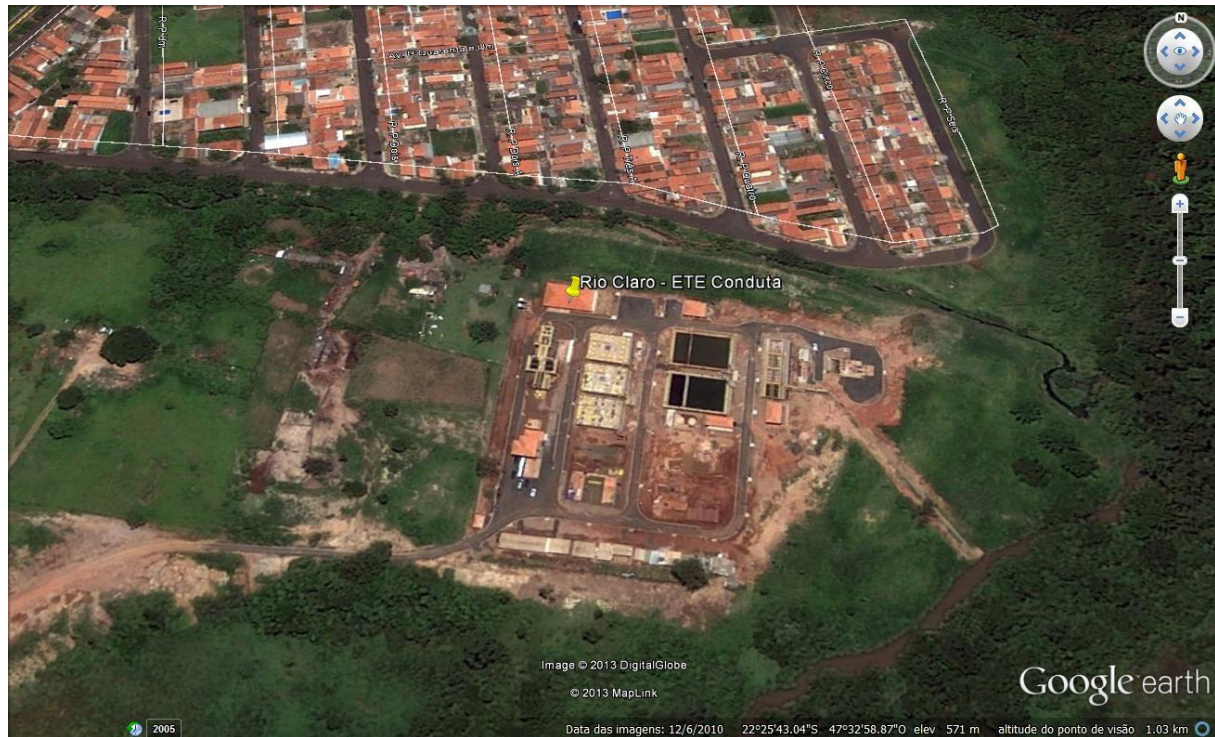
Figura 05 - Imagem de satélite da ETE
