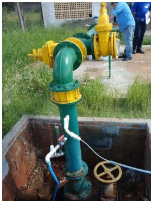
**Descrição(4):** Detalhes dos pontos de inserção das dosagens de cloro e flúor, Registro e uma derivação para captação de água
