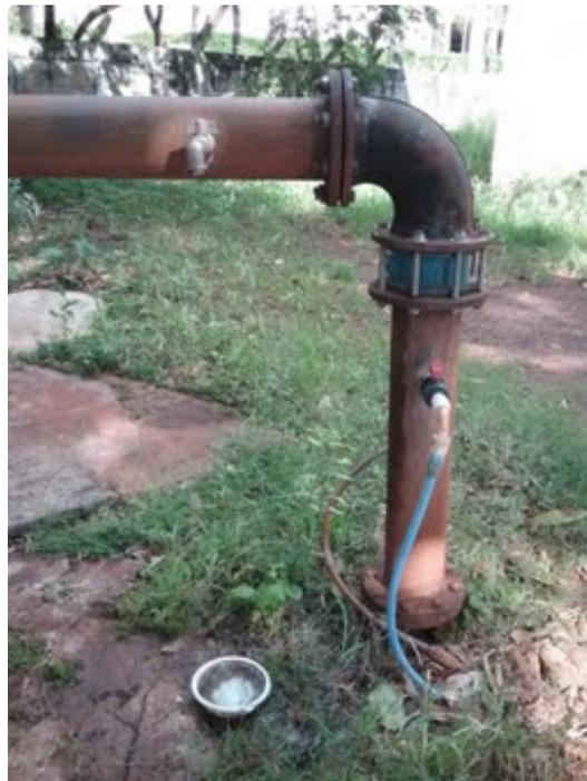
**Descrição(4):** Detalhe da torneira para amostragem e análise da água bruta do poço antes dos pontos de dosagem do cloro e flúor conforme exigido pela legislação de recursos hídricos pertinente.
