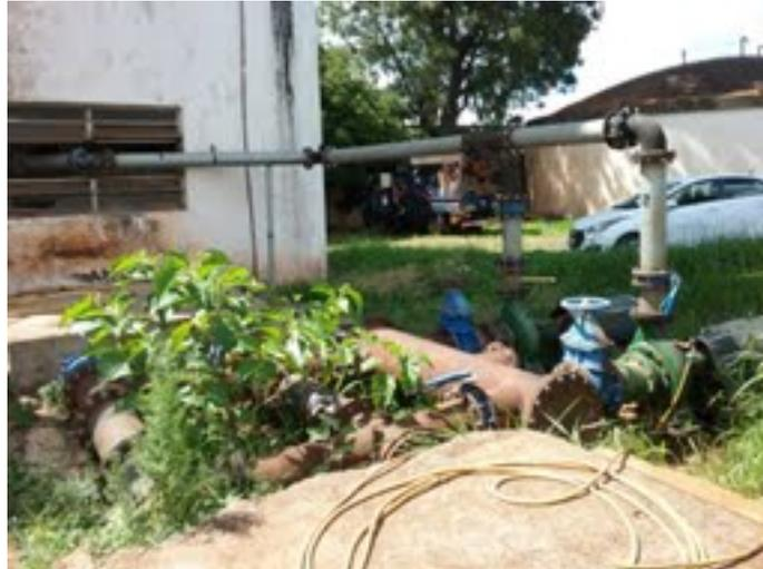
**Descrição(3):** Elevatória de água tratada local, Centro de Reservação Paulista, mostrando o detalhe da tubulação de recalque ao reservatório elevado local
