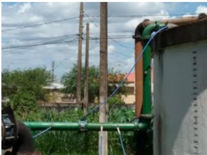
**Descrição(6):** Detalhe dos pontos de inserção das dosadoras de cloro e flúor no cavalete da saída do poço antes do reservatório de água tratada
