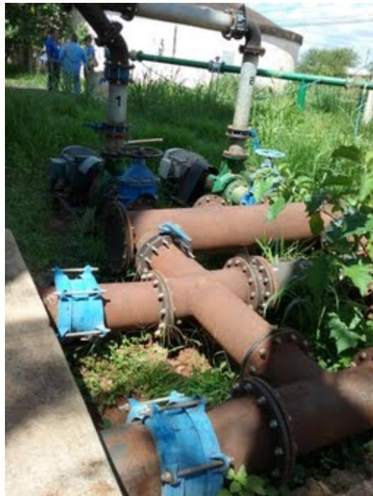
**Descrição(2):** Detalhe do barrilete de adução da água do reservatório enterrado e o recalque ao Reservatório elevado local
