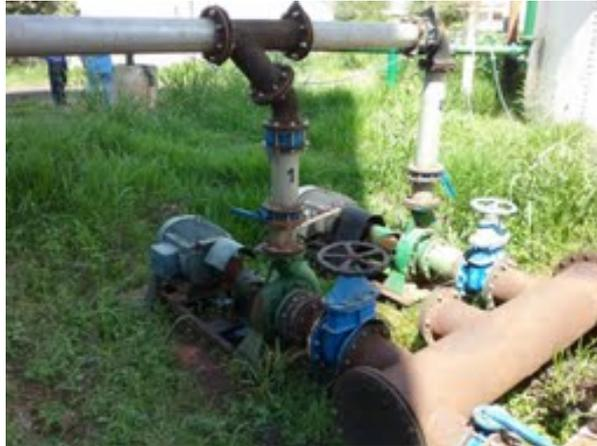
**Descrição(1):** Conjuntos motobombas e os barriletes de adução e recalque instalados sem a proteção de uma casa de bombas e sem um sistema de drenagem adequado visando o direcionamento correto da água de lubrificação das gaxetas das bombas
