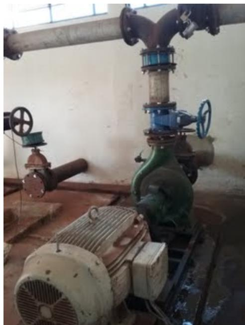
**Descrição(5):** Detalhe do único conjunto motobomba em funcionamento nesta EEAT (potência do motor = 100 CV)
