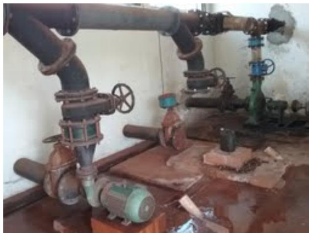
**Descrição(2):** Conjuntos motobombas e tubulações de adução e recalque na casa de bombas e mostrando a falta do sistema de drenagem da água de lubrificação das gaxetas das bombas e sem uma bomba reserva de 100 CV
