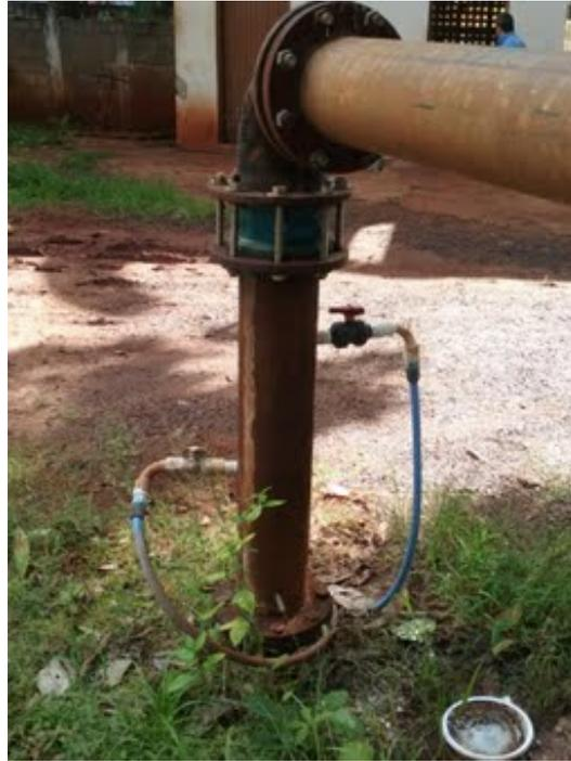
**Descrição(3):** Detalhe dos pontos de inserção na tubulação de saída do poço para a dosagem do cloro e do flúor pelas bombas dosadoras na casa de química ao lado
