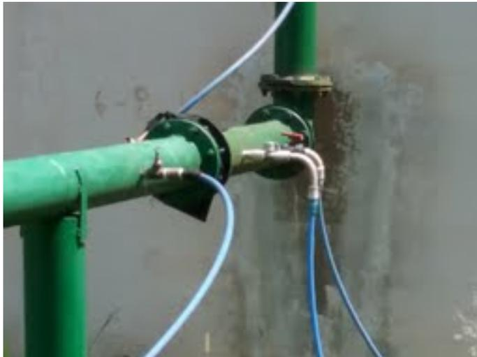
**Descrição(10):** Torneira para amostragem e análise da água bruta do poço e na sequência pontos de inserção da dosagem do cloro e flúor
