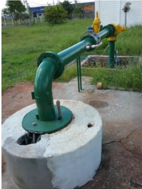
**Descrição(1):** Poço e cavalete de recalque com todos os equipamentos exigíveis pela Portaria DAEE de Outorga
