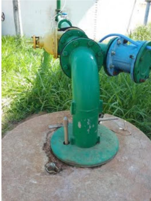
**Descrição(8):** Detalhe do tubo de medição de nível em pvc marrom e de registro e ponto de derivação de água
