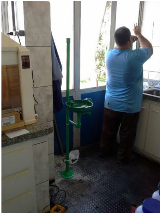
Descrição(4): Chuveiro de emergência, cuja necessidade foi apontada no Diagnóstico, sendo instalado
