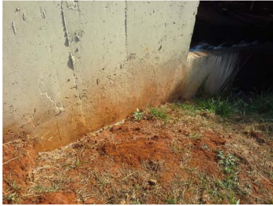
Descrição(3): Vazamento reparado na Calha Parshall de saída
