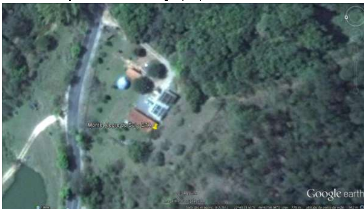
Figura 3 – Estação de Tratamento de Água - ETA
