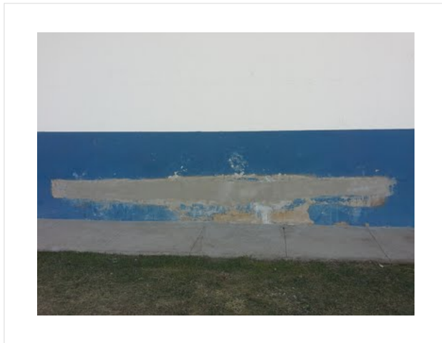
Descrição(7): Vazamento reparado na caixa de entrada da sala de desinfecção por UV
