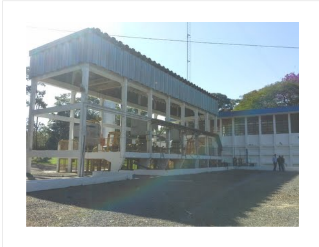
Descrição(3): Aspecto geral da elevatória
