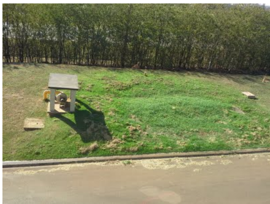
Descrição(5): Controle de odores (bio filtro)
