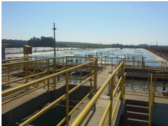
Descrição(6): Desarenadores e lagoas aeradas ao fundo
