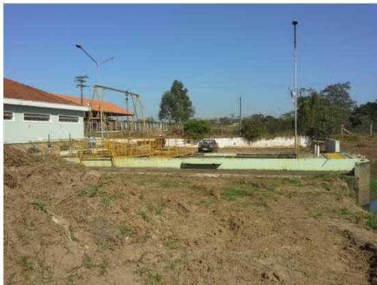
Descrição(3): Tomada de água, gradeamento e desarenadores
