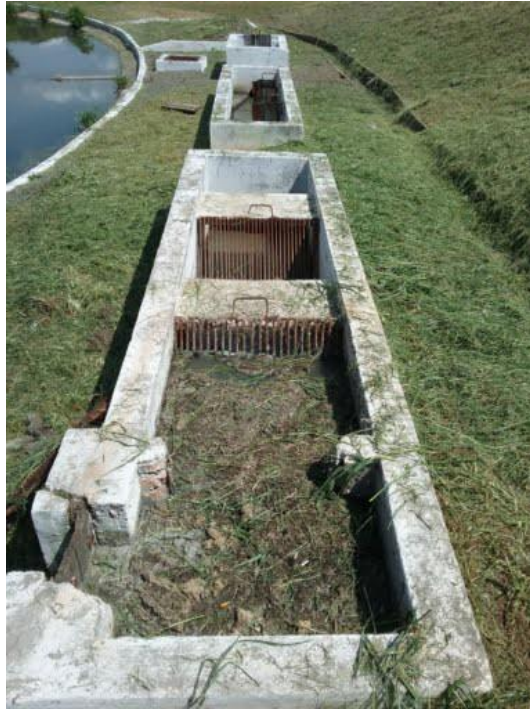
Descrição(4): Entrada do esgoto bruto com o gradeamento grosso e fino na sequência do canal Imagem(5)
