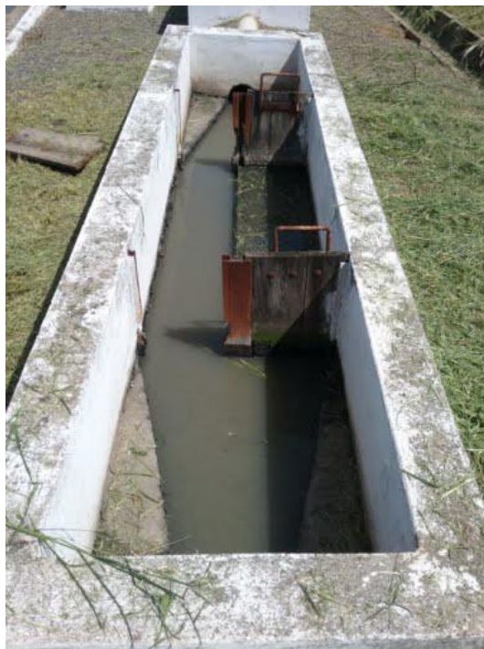
Descrição(4): Entrada do esgoto bruto com o gradeamento grosso e fino na sequência do canal Imagem(5)
