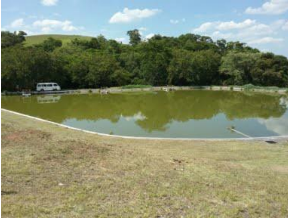
Descrição(2): Lagoa facultativa
