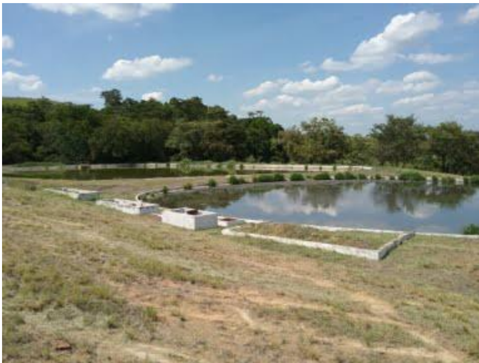
Descrição(3): Vista geral da ETE Ipiranga
