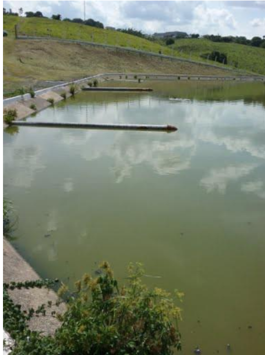
Descrição(10): Vista das duas tubulações de alimentação da lagoa facultativa
