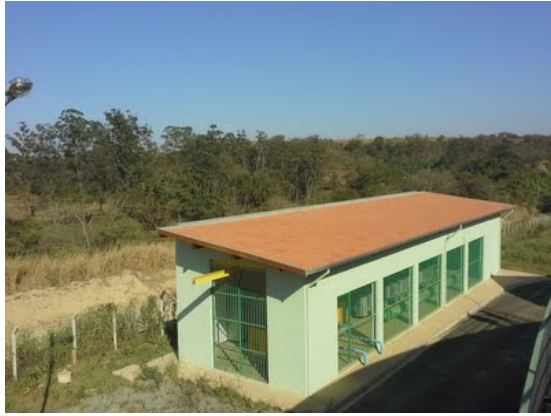
Descrição(3): Casa de desinfecção com radiação ultravioleta
