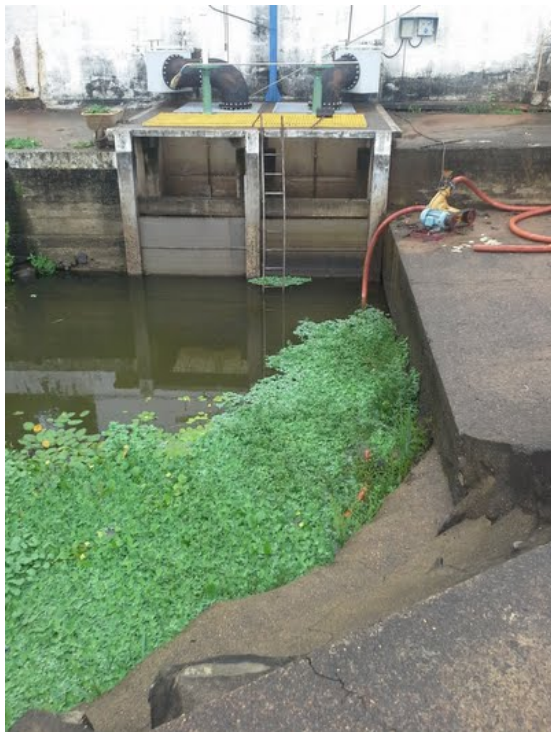
Descrição(3): Tomada de agua
