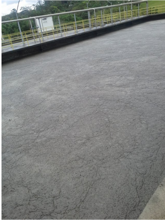
Descrição(2): Tanque de aeração
