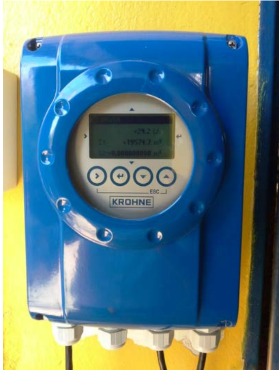
Descrição(2): Medidor de vazão em operação
