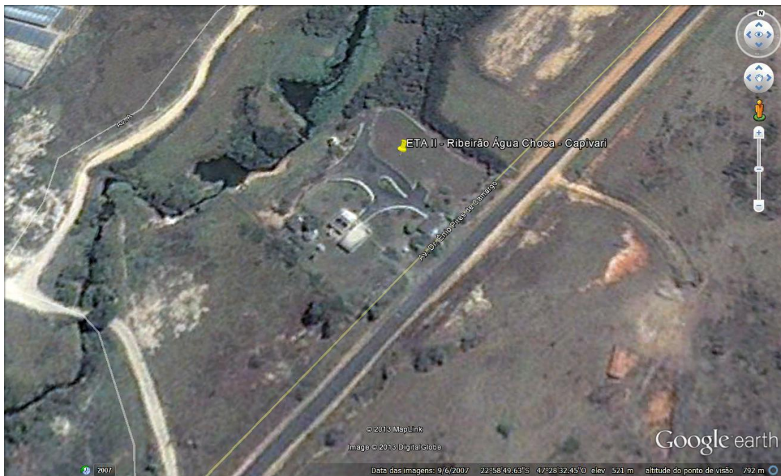
Figura 2 - Captação no Ribeirão Água Choca e ETA II
