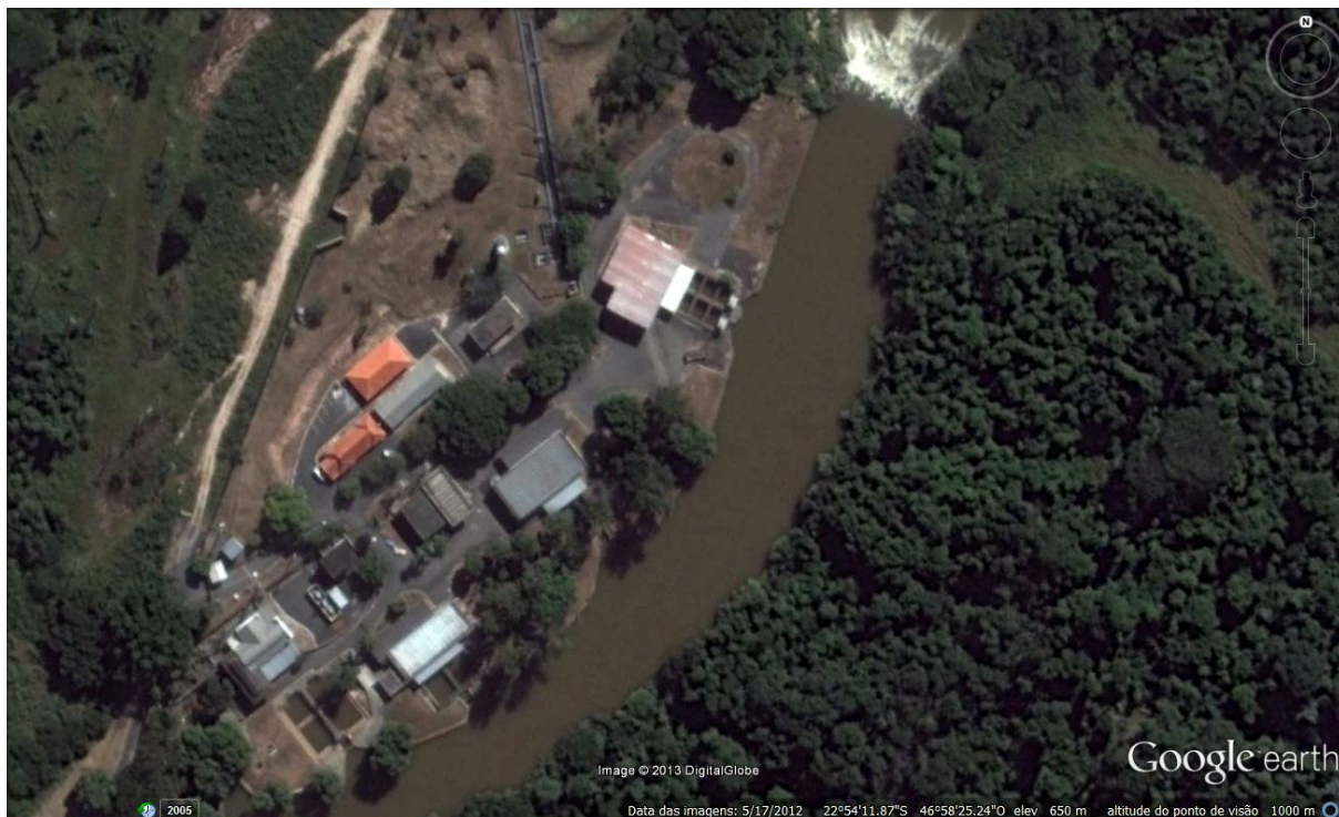
Figura 2 - Estação de captação de água do Rio Atibaia
