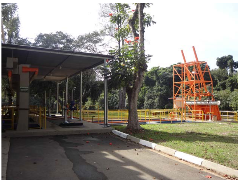
Vista geral da captação no Rio Atibaia
