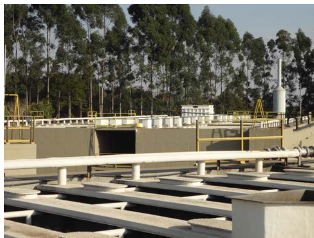
Figura 2 - Reatores anaeróbios
