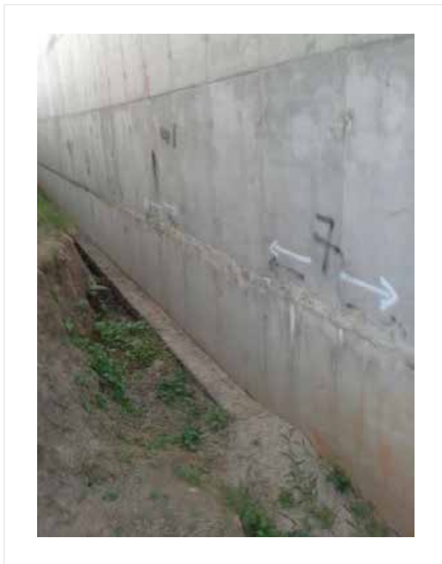
Descrição(7): Tanque de aeracao
