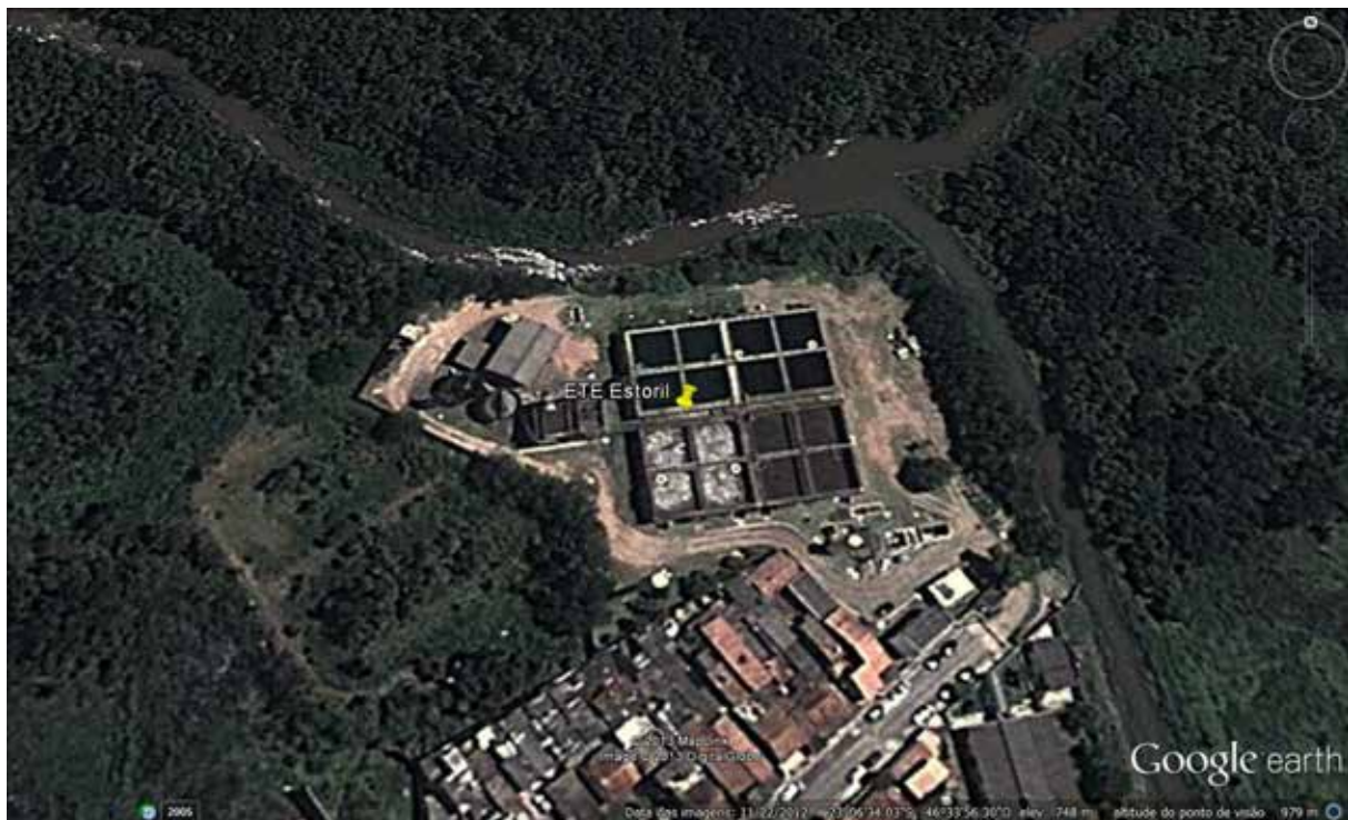
Figura 5 - Imagem de satélite da ETE Estoril
