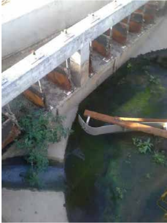
Descrição(2): Oxidação do defletor
