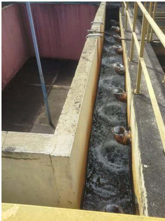
Descrição(7): Saída decantador
