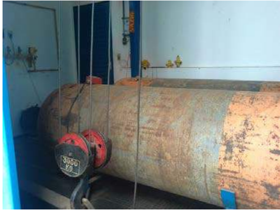
Descrição(12): Cilindros de cloro
