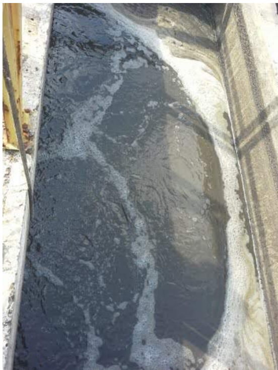
Descrição(4): Detalhe aeração
