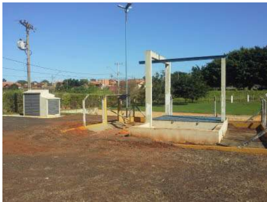
Descrição(4): Poço de sucção
