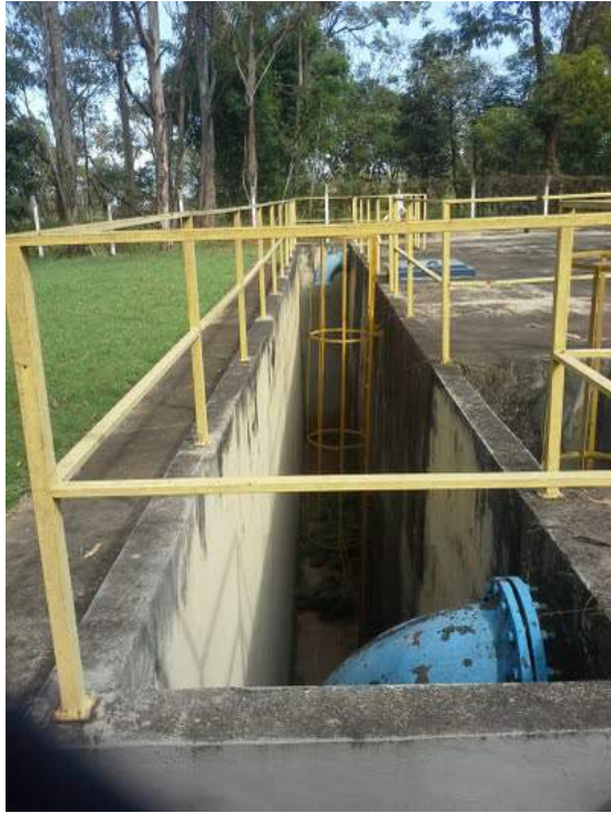
Descrição(3): Detalhe guarda corpo
