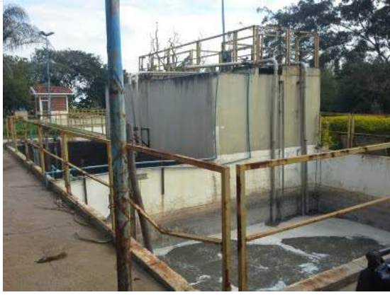
Descrição(2): Lodos ativados por batelada
