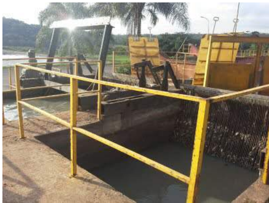
Descrição(8): Detalhe gradeamento grosso
