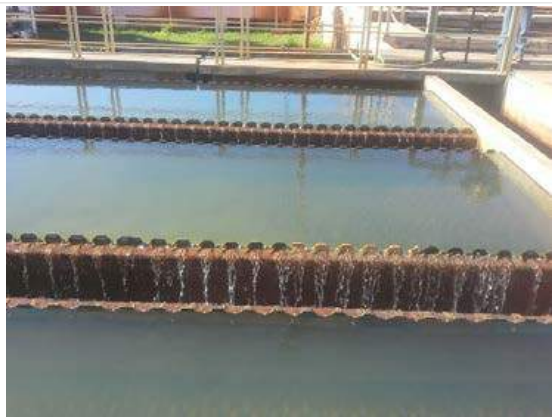
Descrição (10): Detalhe vertedores do decantador consertado
