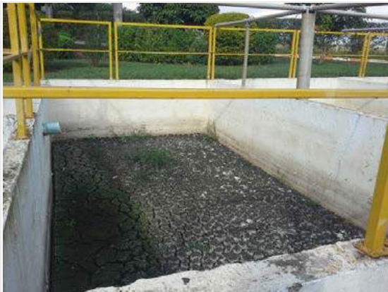
Descrição(7): Leito secagem de lodo
