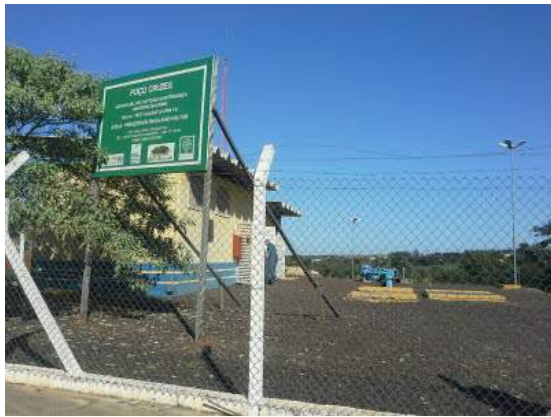
Descrição(1): Acesso e identificação poço cruze
