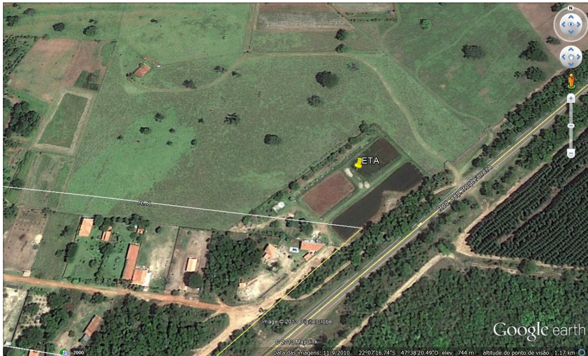
Figura 03 - Imagem de satélite da Estação de Tratamento de Água
