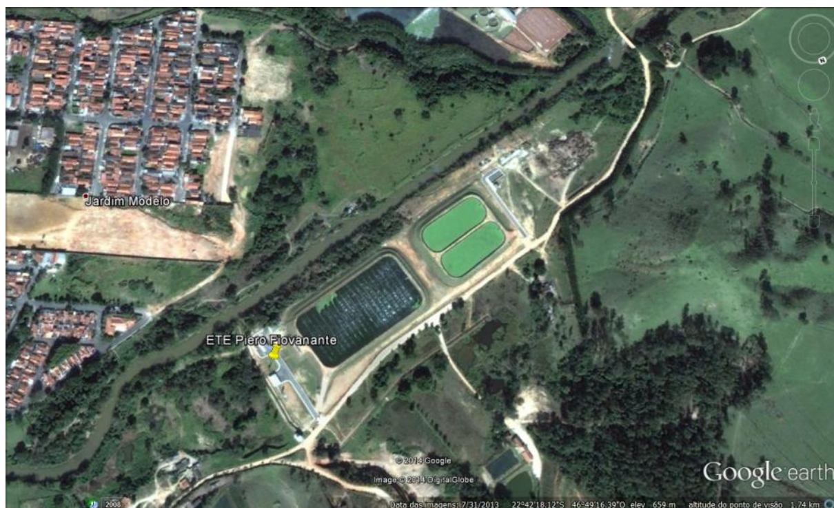
Figura 3 – Estação de Tratamento de Esgoto (ETE) – ETE Piero Fioravante
