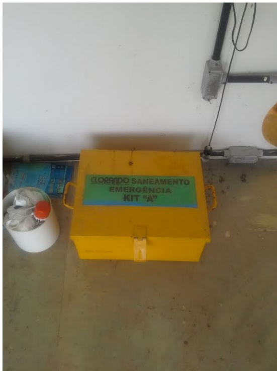
Descrição(9): Kit de emergência gás cloro
