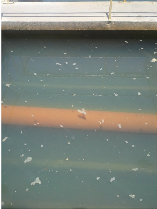
Descrição(4): Alta passagem de flocos para os filtros.
