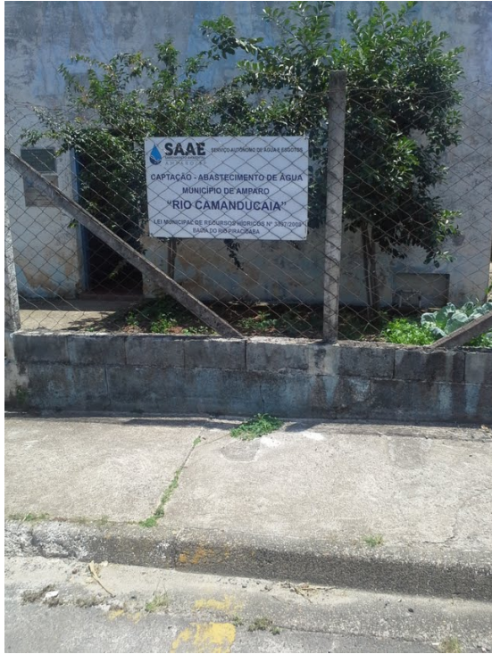
Descrição(2): Entrada captação
