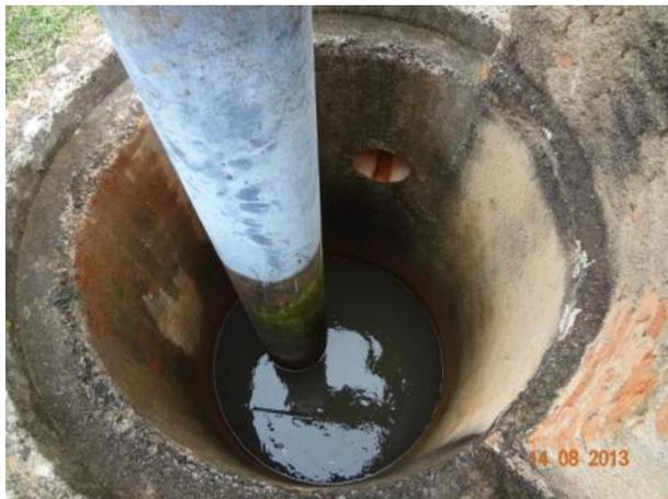
Figura 6 - Poço de sucção
