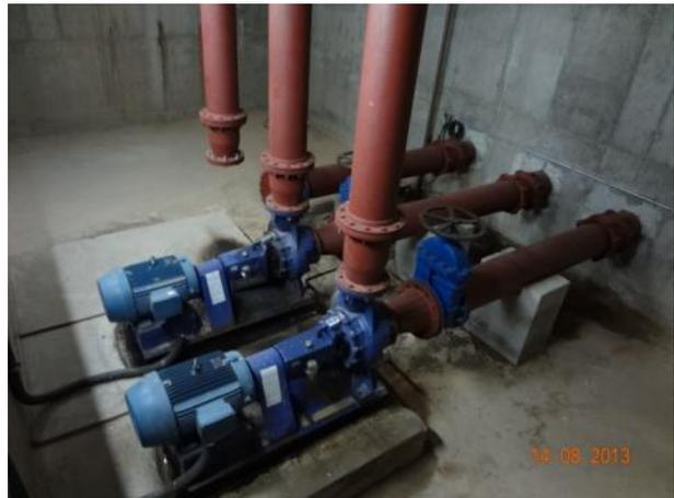
Figura 66 - Bombas de recalque da ETE Capivari
