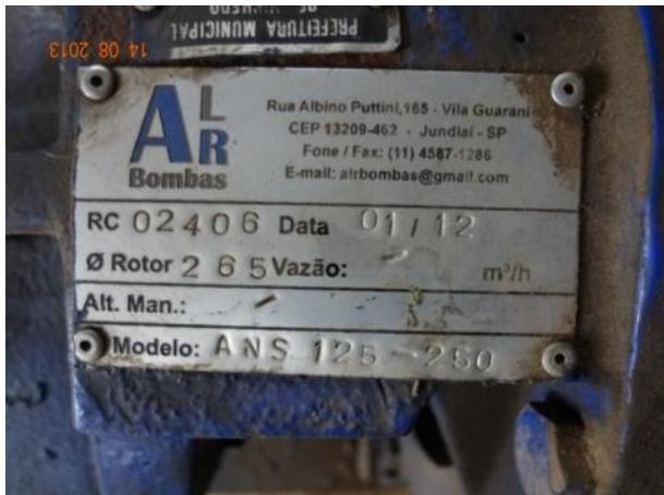
Figura 14 - Placa de identificação das condições operacionais do conjunto moto-bomba sem a determinação dos parâmetros
