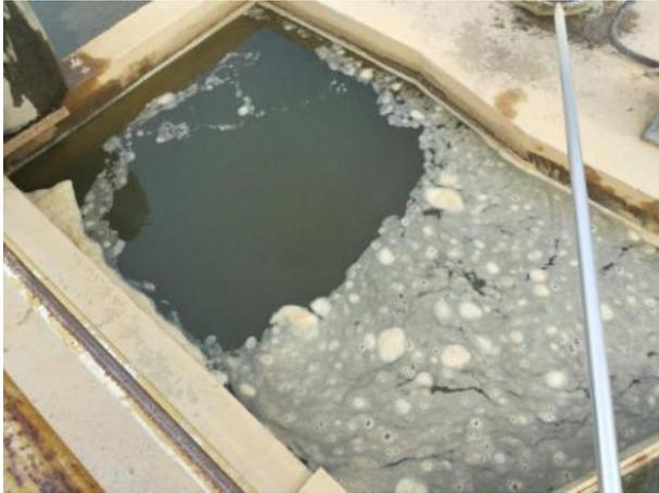
**Figura 29 - Detalhe para a formação de sobrenadantes no flocculador**
