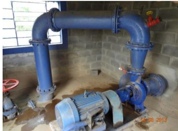
Figura 13 - Casa de bombas da Estação Elevatória
