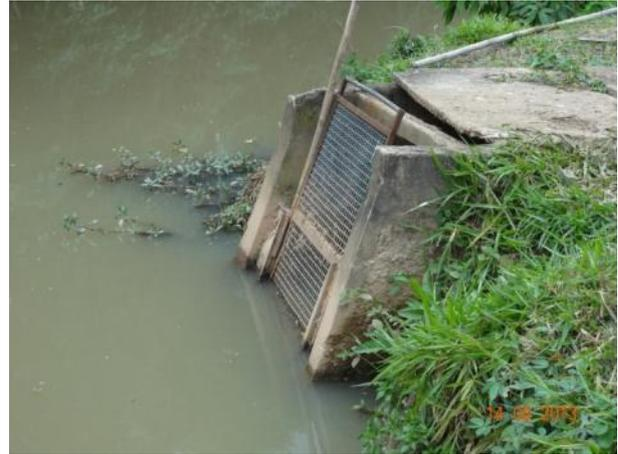
**Figura 9 - Tela de proteção da tomada de água**
