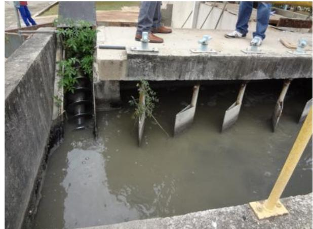
**Figura 51 - Caixa de areia com eixo para a retirada de sólidos sedimentáveis**
