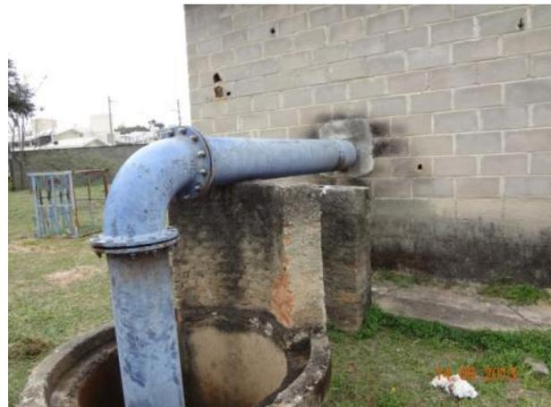
Figura 7 - Tubulação de entrada da Estação Elevatória
