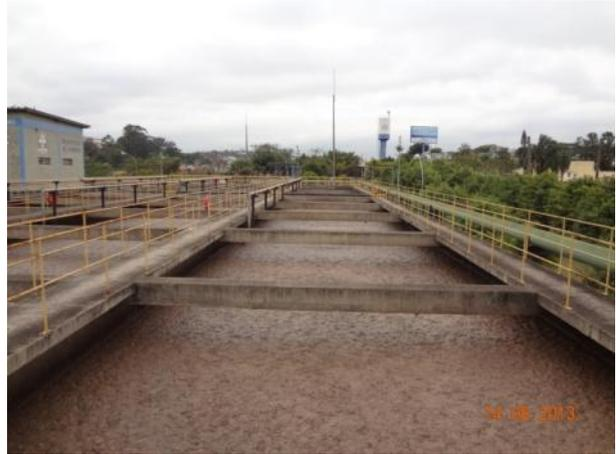
Figura 53 - Aerador operado com ar difuso no reator de lodos ativados
