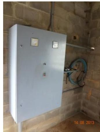
Figura 15 - Painel elétrico da casa de bombas
