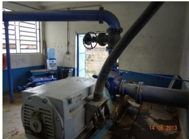
Figura 26 - Conjunto moto-bomba instalado no local
