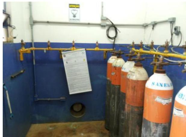
Figura 43 - Armazenamento do gás cloro
