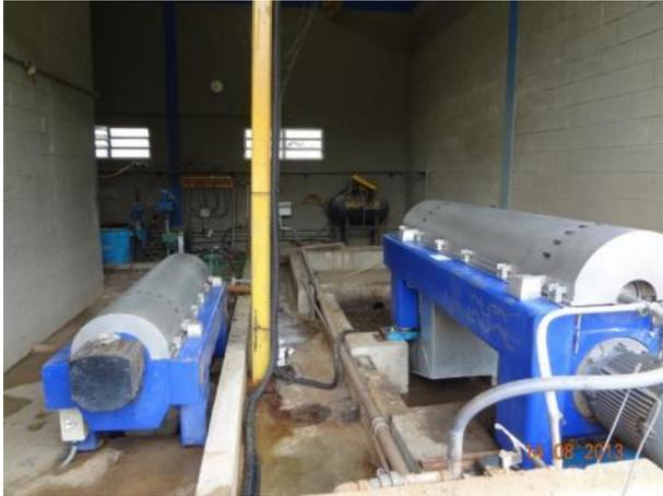
Figura 58 - Centrífugas (desidratação do lodo)
