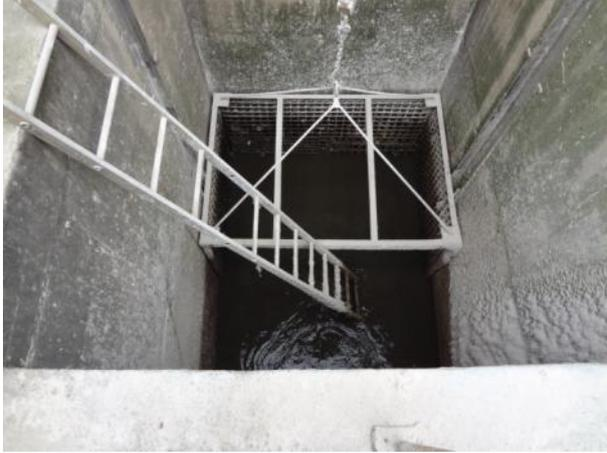
**Figura 88 - Poço de sucção com grade grossa**
