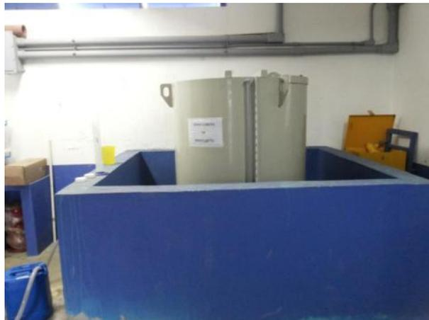
Figura 44 - Tanque de contenção do hipoclorito de sódio
