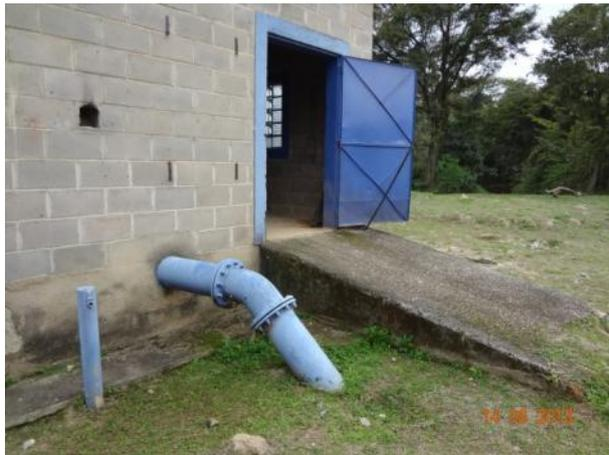
Figura 12- Tubulação de saída da Estação elevatória
