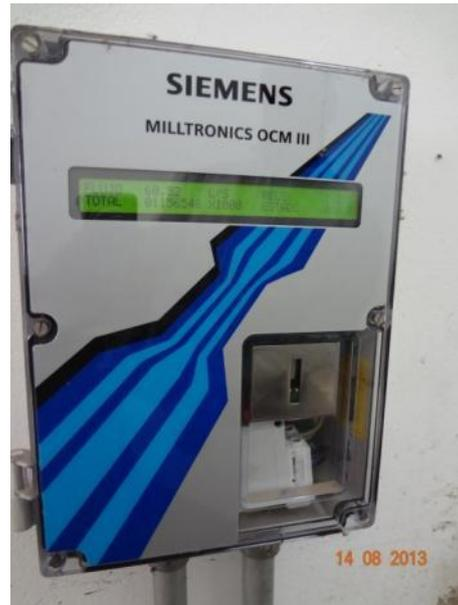
Figura 70 - Painel do macromedidor ultrassônico instalado na saída da calha Parshall
