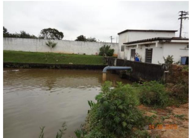
Figura 18 - Tubulação para recalque da água pela estação elevatória existente no local
