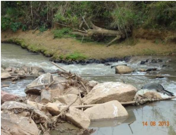
**Figura 10 - Enrocamento do Rio Capivari (detalhe para as paredes escuras das rochas)**
