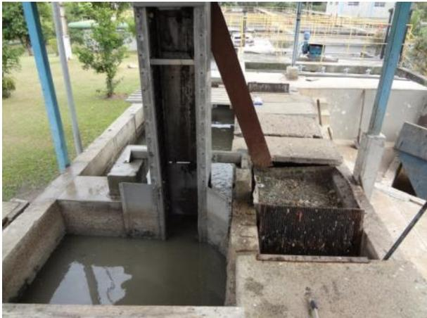
**Figura 50 - Sistema de gradeamento fino**
