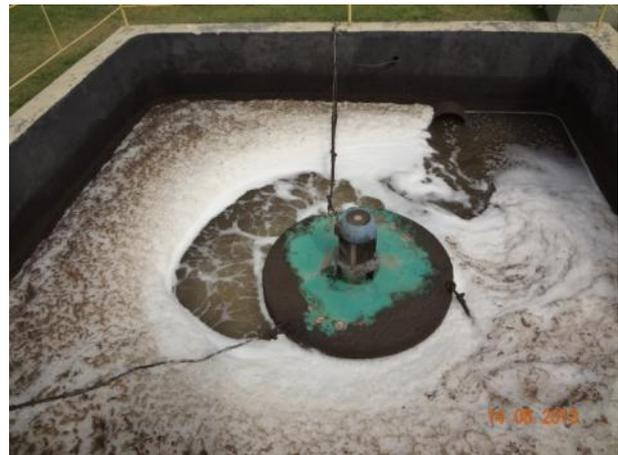
Figura 72 - Aeração final do efluente
