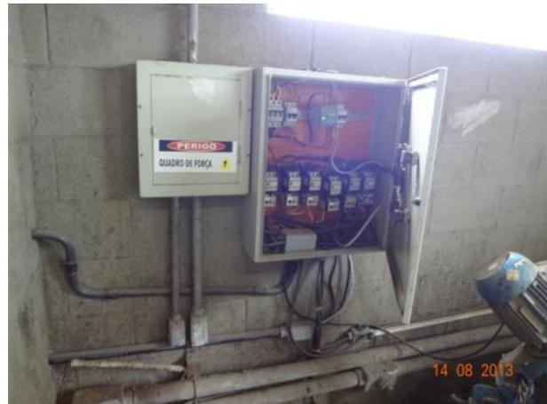
Figura 61 - Quadro de componentes elétricos
