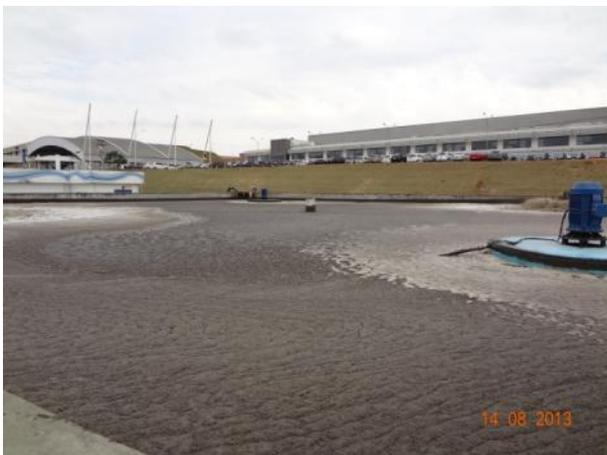
Figura 67 - Reator de lodos ativados por aeração
