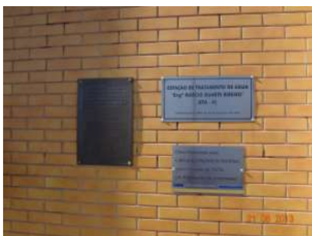
Figura 61 - Placa de inauguração da ETA II
