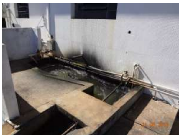
Figura 31 - Entrada do efluente e recebimento do carvão ativado e cal hidratada
