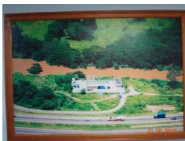
Figura 62 - Vista da captação Atibaia (detalhe para a elevada turbidez da água)
