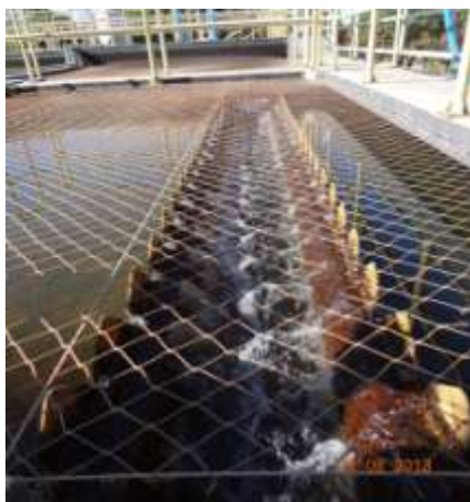
Figura 74 - Vertedouros do tanque de decantação
