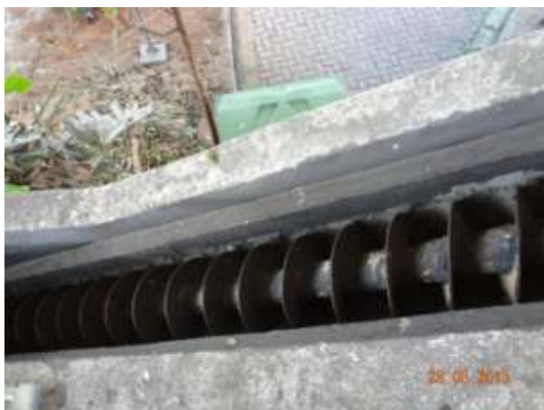
Figura 97 - Transporte dos sedimentos
