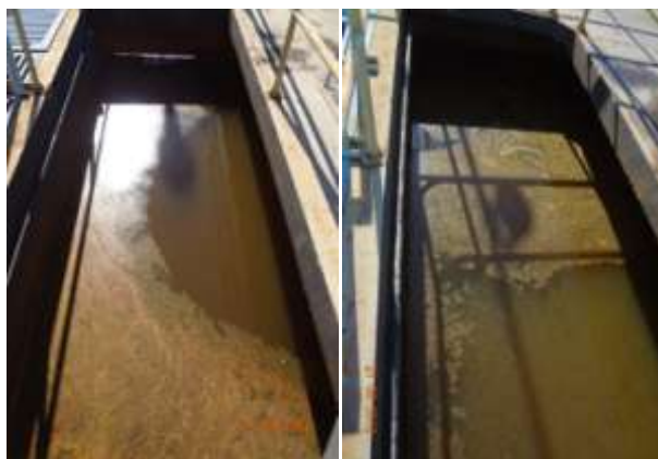
Figura 71 - Detalhe para a elevada quantidade de sobrenadantes nos floculadores
