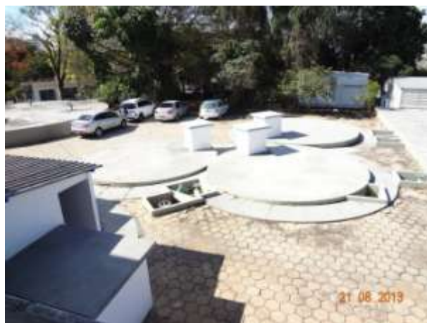
Figura 46 - Reservatórios utilizados para lavagem dos filtros
