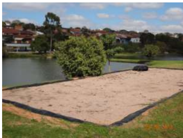
Figura 104 - Local destinado ao tratamento do lodo por uso de "bag" (plano de contingência)
