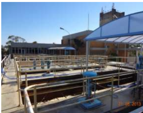
Figura 70 - Vista geral dos tanques de floculação
