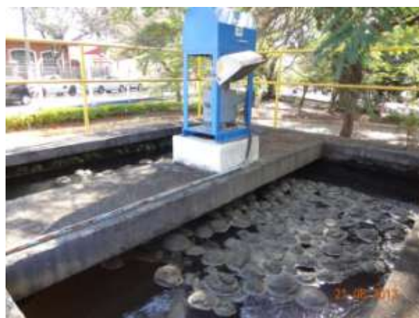
Figura 38 - Floculador com flocos sobrenadantes
