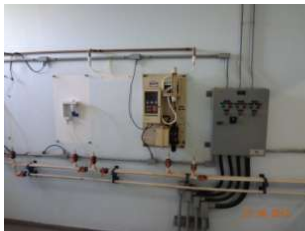
Figura 77 - Bombas dosadoras
