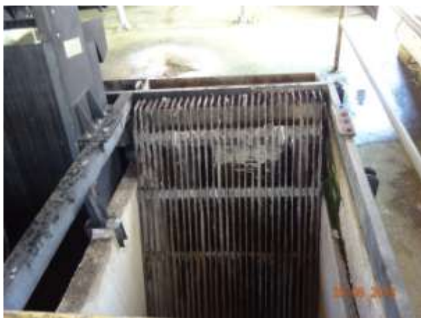
Figura 83 - Gradeamento Grossoiro
