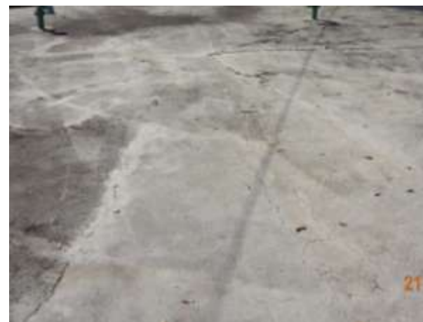
Figura 56 - Reservatório de distribuição semi-enterrado (detalhes para a formação de ranhuras)
