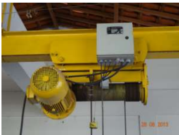
Figura 87 - Sistema de içamento das bombas
