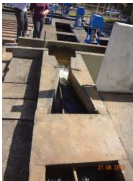
Figura 32 - Calha Parshall
