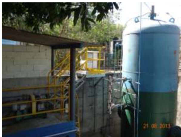
Figura 20 - Reservatório Hidropneumático
