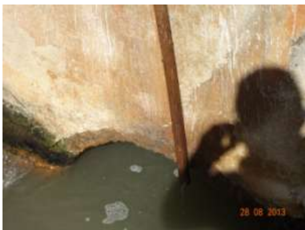
Figura 105 - Tubulação contendo anti-espumante
