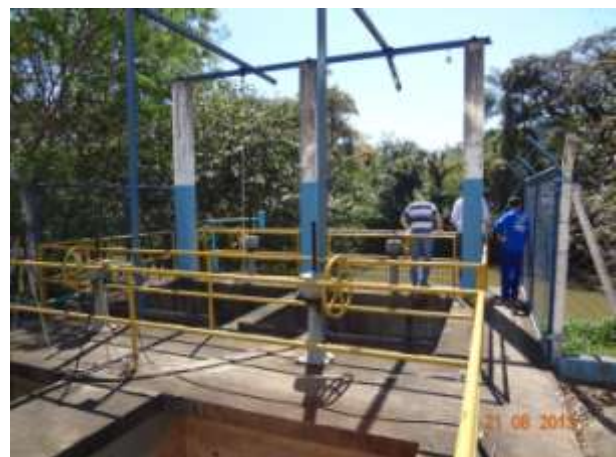
Figura 11 - Vista do sistema do desarenador em direção a tomada de água
