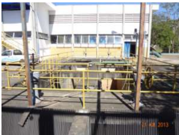
Figura 10 - Vista do gradeamento, desarenador e Estação de elevatória de água (ao fundo)
