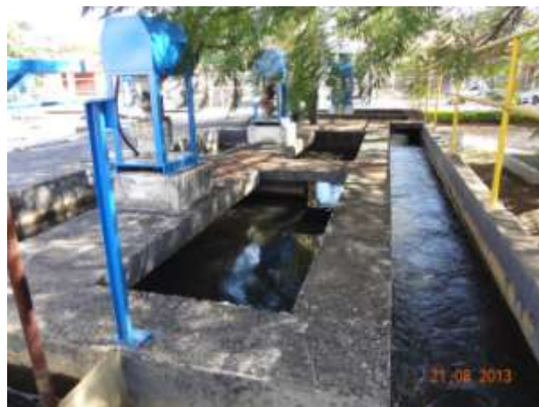
Figura 36 - Entrada do floculador
