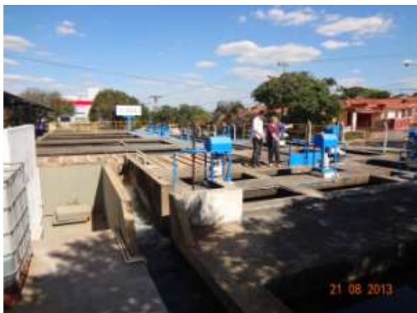
Figura 35 - Vista geral da ETA
