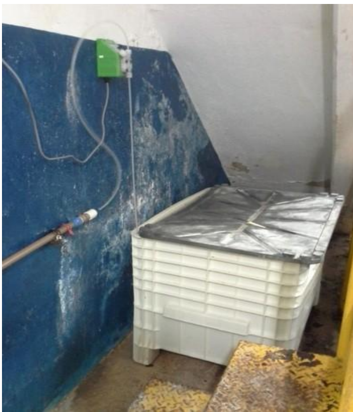
Descrição(11): Aplicação de Ortopolifosfato de Sódio
