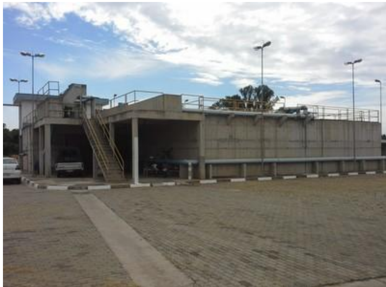
Descrição(2): ETE Central
