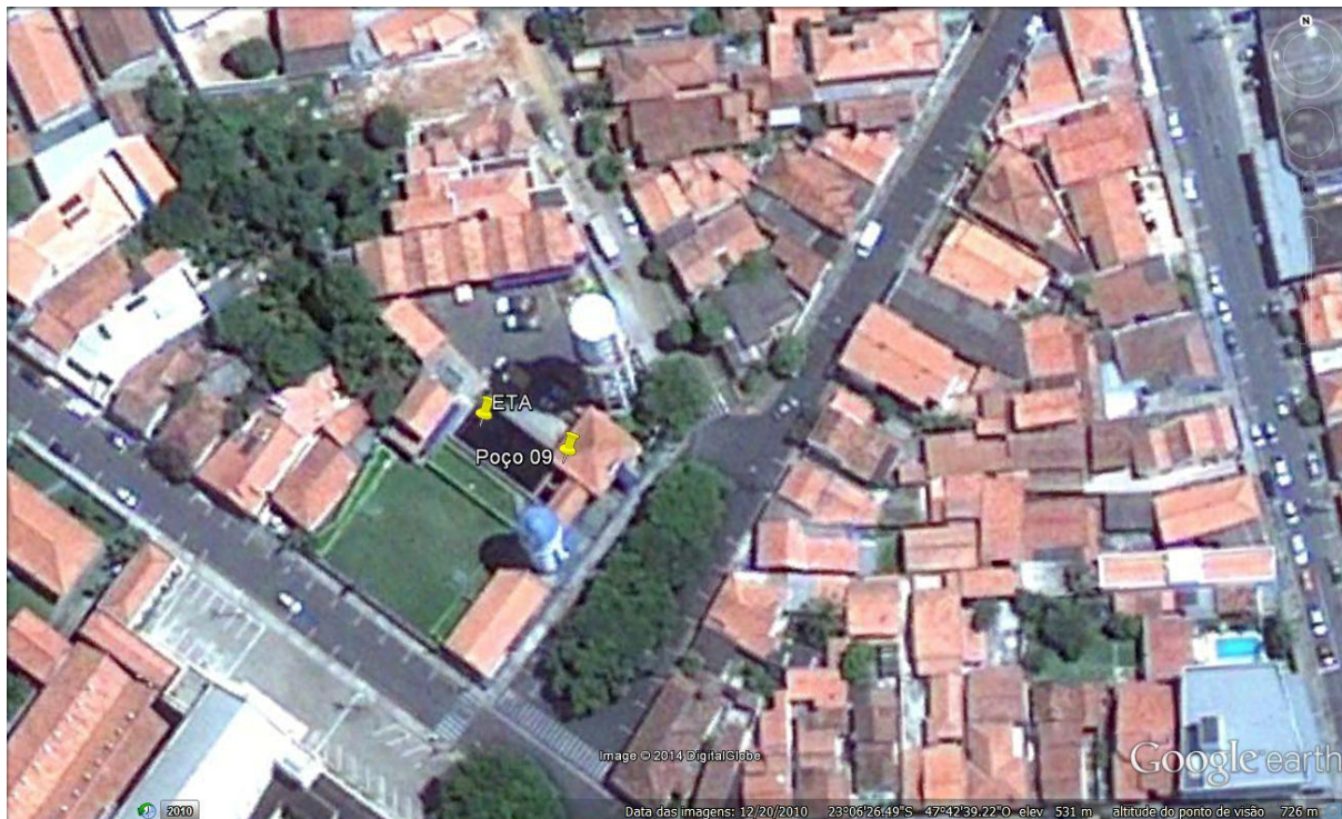
Figura 6 – Imagem de satélite da ETA Central
