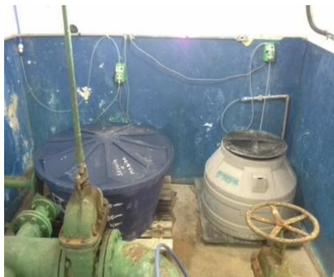
Descrição(9): Pré-cloração (à esquerda) e aplicação de Ácido Fluorsilícico (à direita)
