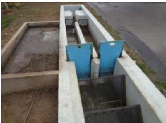
**Figura 46 - Chegada do esgoto bruto: gradeamentos grosseiros e desarenadores**
