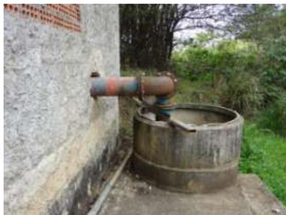
Figura 20 - Poço de sucção
