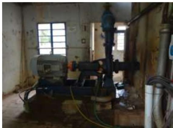
**Figura 10 - Conjunto de recalque (125 CV)**
