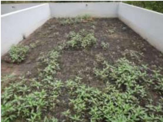
Figura 54 - Leito de secagem de lodo
