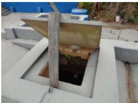
**Figura 42 - Tampa de inspeção**
