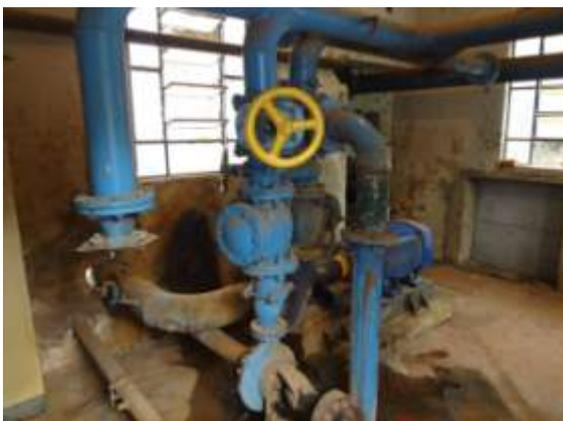
**Figura 9 - Conjunto de recalque (100 CV)**
