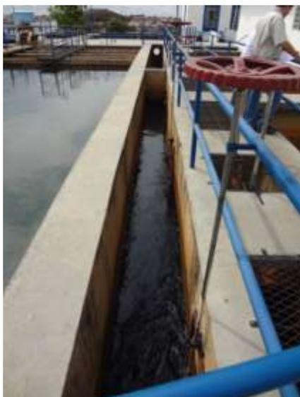
**Figura 32 - Canal de entrada da água decantada para os filtros**
