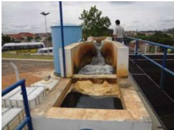
**Figura 27 - Chegada da água bruta a calha Parshall**
