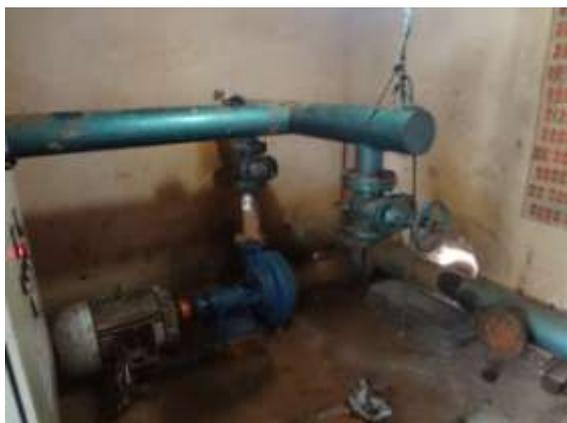
**Figura 21 - Conjunto de recalque**
