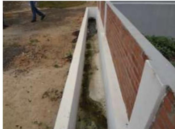
Figura 55 - Canaletas de drenagem do percolado dos leitos de secagem
