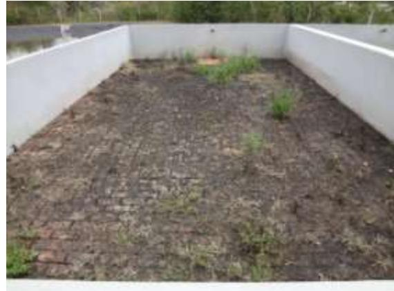
Figura 53 - Leito de secagem de lodo
