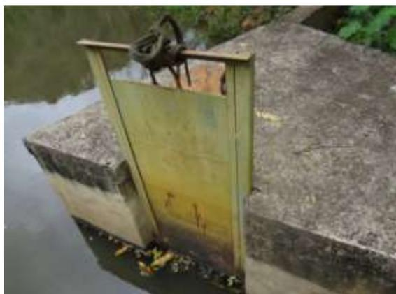
Figura 19 - Comporta da tomada d'água
