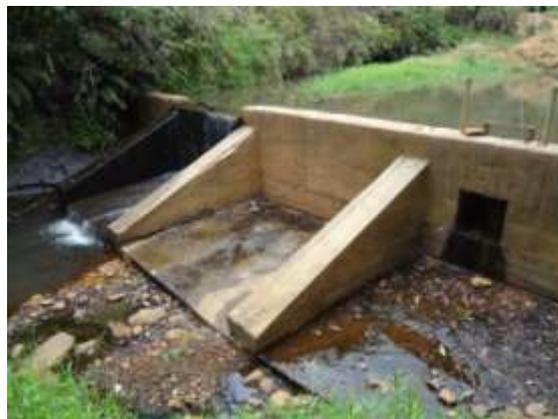
Figura 18 - Barramento de nível para captação no Ribeirão Samambaia
