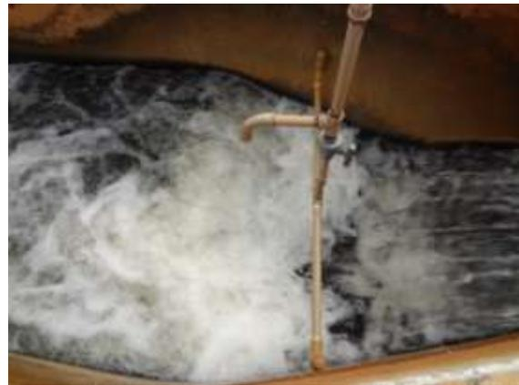
**Figura 28 - Aplicação de coagulante e pré-cloração**
