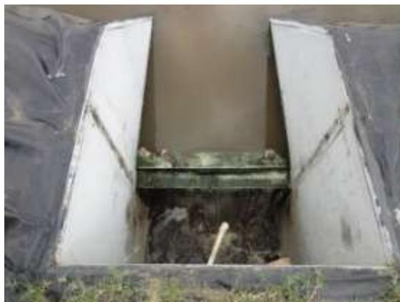
**Figura 51 - Saída do efluente tratado e cloração**
