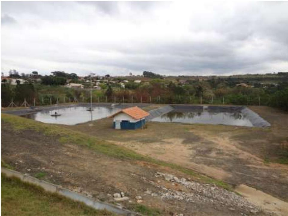
**Figura 45 - Lagoas aeradas e de maturação e casa de bombas para recirculação de lodo e recalque para leito de secagem**
