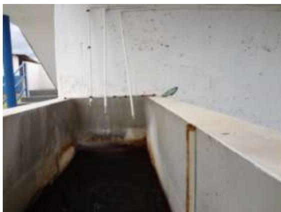
**Figura 34 - Aplicação de Cloro e Flúor na água filtrada**
