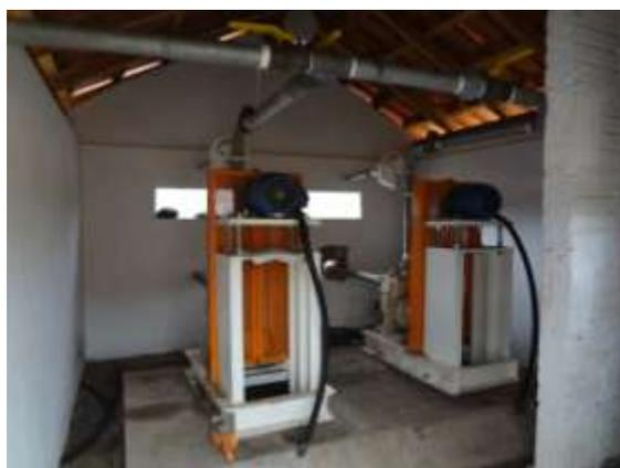
**Figura 49 - Recalque para recirculo de lodo e leito de secagem de lodo**
