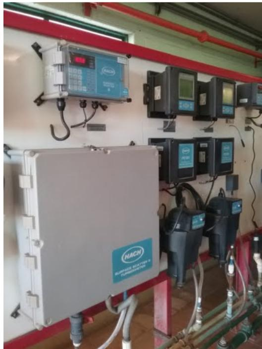
**Descrição(10):** Turbidímetro da água bruta, decantada, e tratada.
