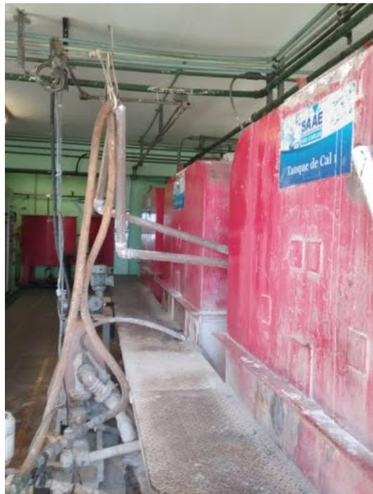
**Descrição(8):** Tanques de cal. Será substituído por hidróxido de cálcio.
