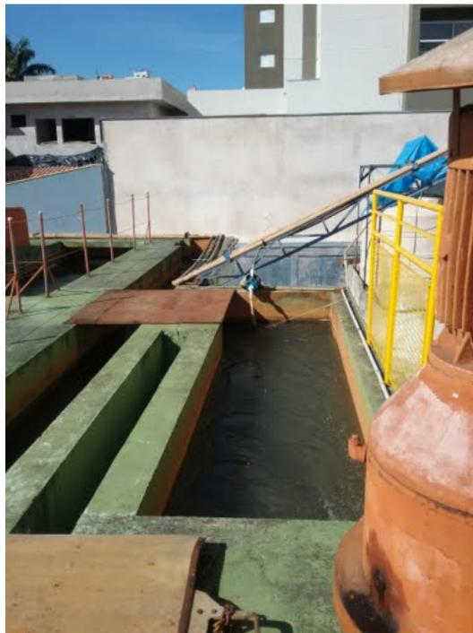
**Descrição(4):** Bomba de recalque para análise de pH, após adição de cal hidratada
