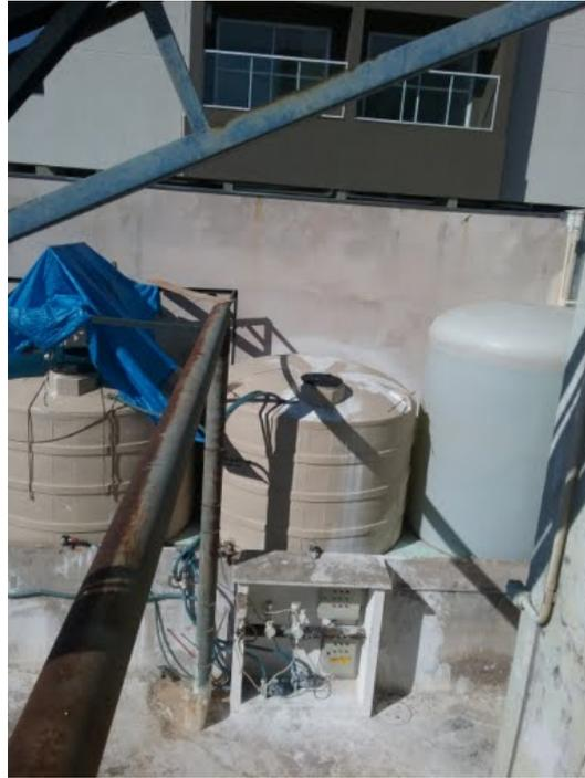
**Descrição(9):** Armazenamento do cloro gerado, e hidróxido de cálcio. Está sendo adaptado.
