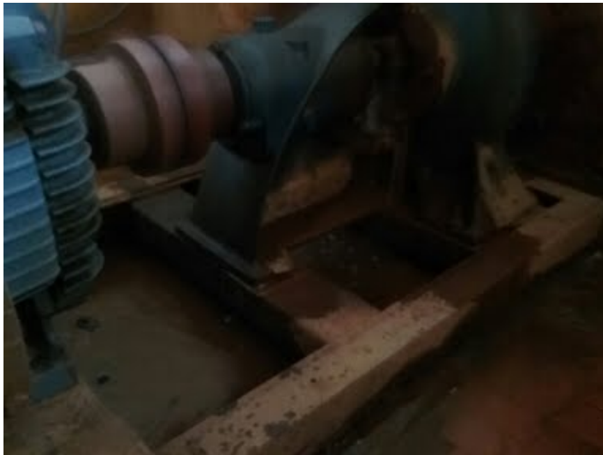
Descrição(5): Drenagem deficiente
