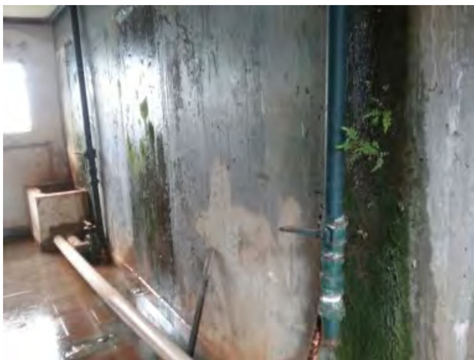
Descrição: Sinais de infiltração FOTOS(4)
