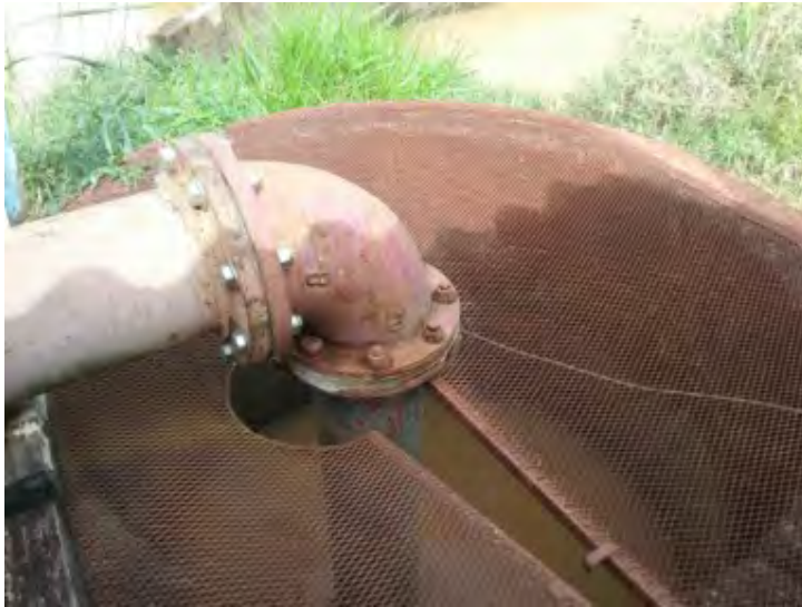
Descrição(5): Sucção da água bruta Imagem(6)
