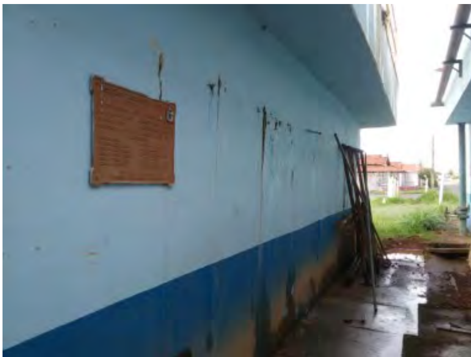
Descrição: Sinais de infiltração FOTOS(4)
