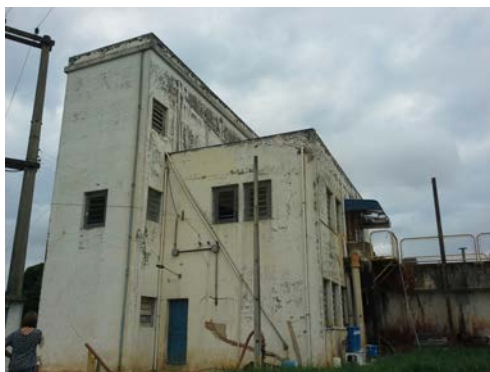
Descrição(17): Prédio da ETA
