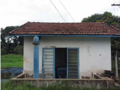
Descrição(10): Casa de bombas da captação
