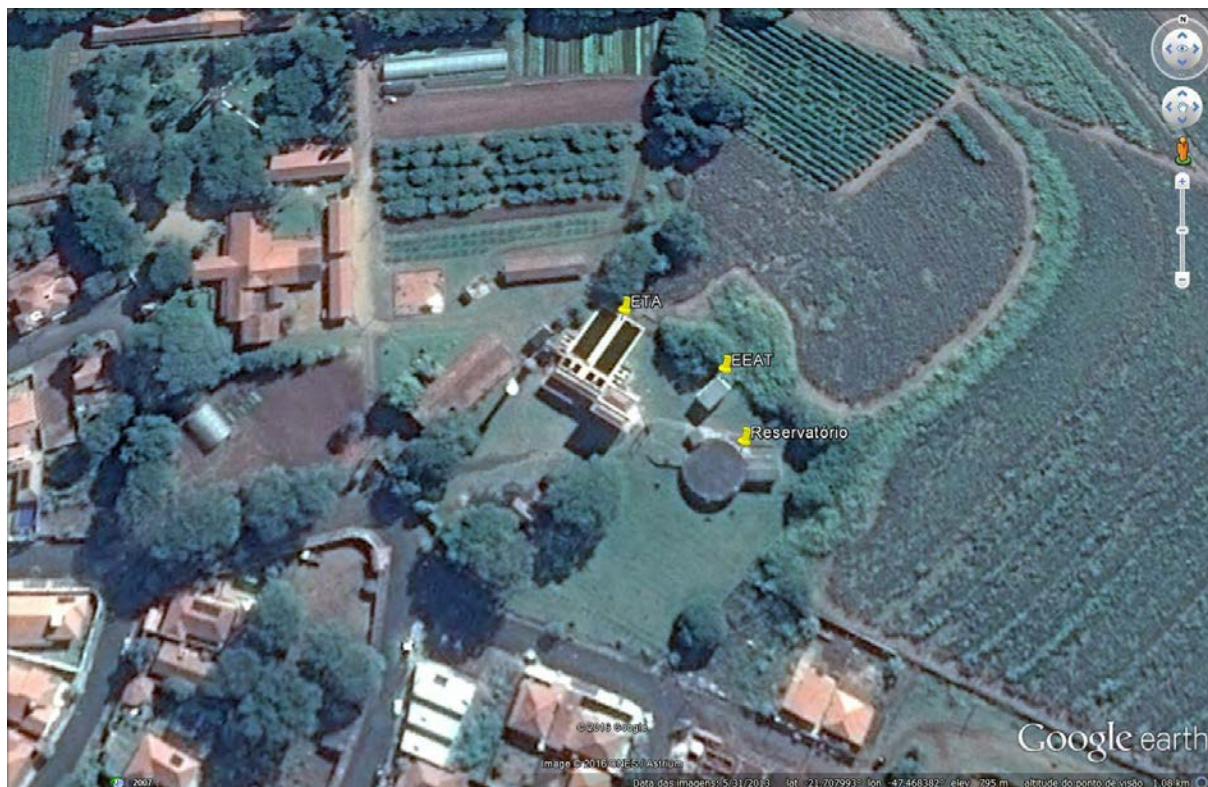
Figura 6: Imagem de satélite da área da ETA, reservatório e EEAT
