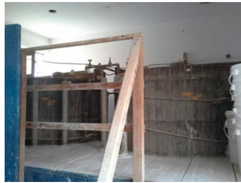
Descrição(12): Armazenamento de sulfato alumínio desativado Imagem(14)
