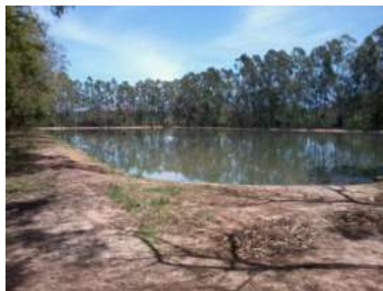
Figura 5 - Aspecto da ETE
