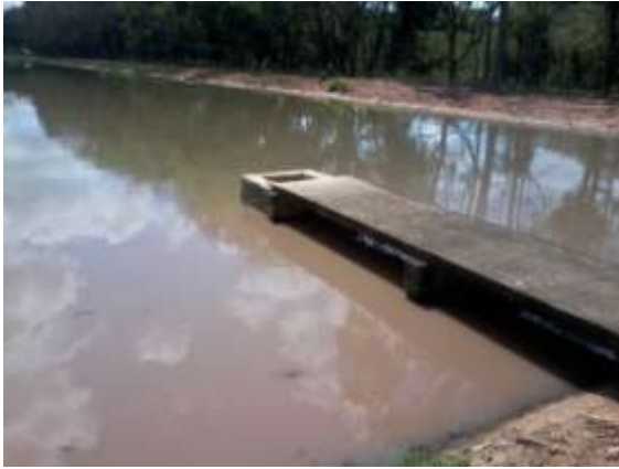
Figura 10 - Dispositivo de saída do efluente tratado
