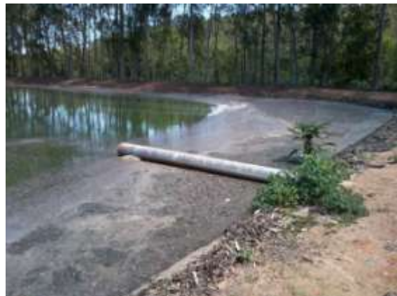
Figura 9 - Entrada de esgoto na ETE e acúmulo de gordura (sobrenadante)
