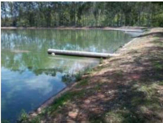
Figura 8 - Entrada de esgoto na ETE
