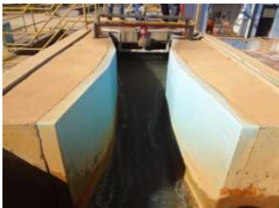
**Figura 15 - Calha Parshall de entrada da ETA**
