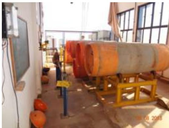
Figura 22 - Cilindros de armazenamento de cloro gás
