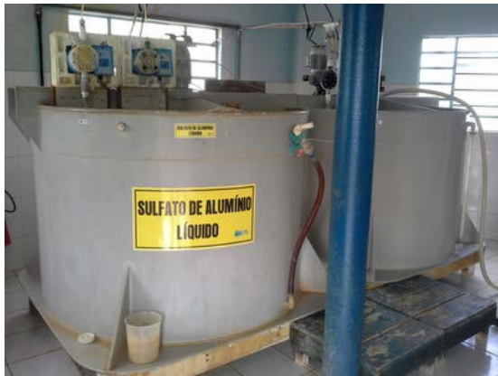
Descrição(4): Sulfato de Alumínio e barrilha
