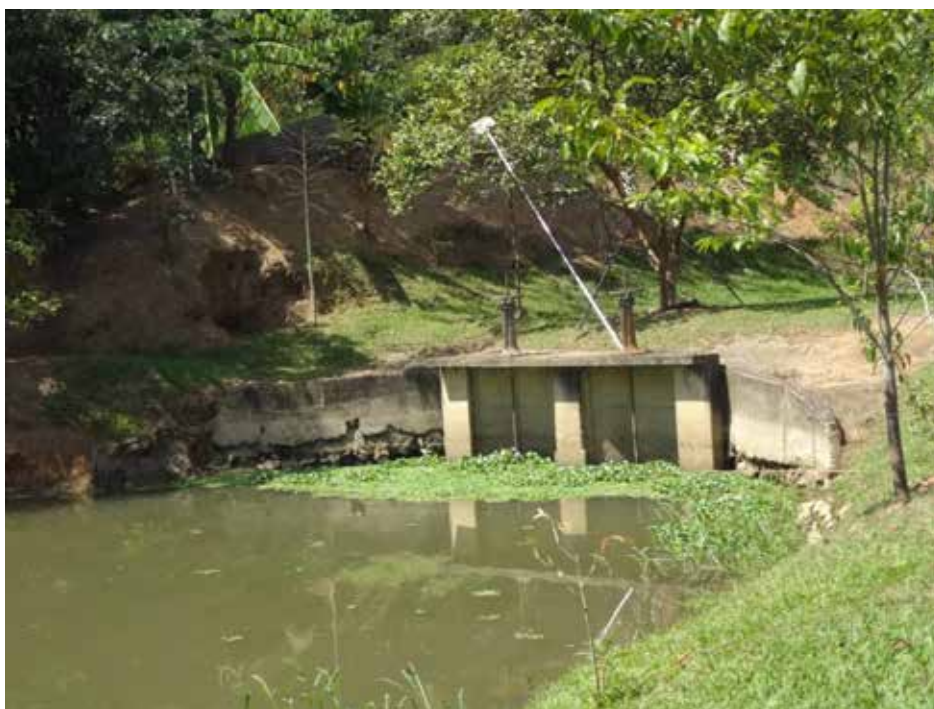
Figura 5 - Tomada d'água na Captação no Ribeirão Pirai
