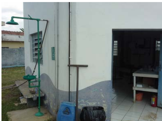
Descrição(7): Chuveiro de emergência e extintor de incêndio
