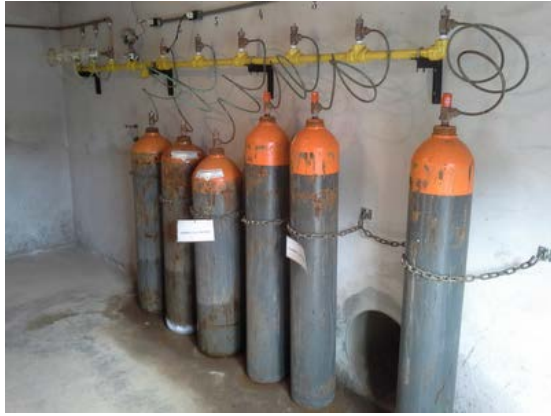
Descrição(14): Cilindros de Cloro
