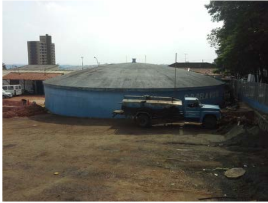
Descrição(1): Apoiado da ETA
