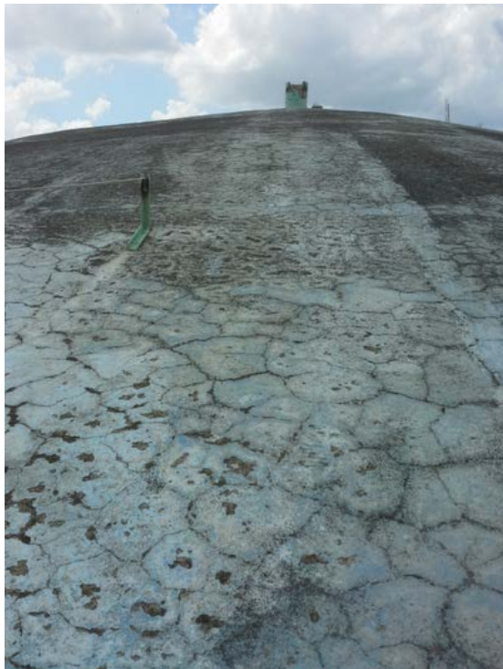
Descrição(4): Laje de cobertura
