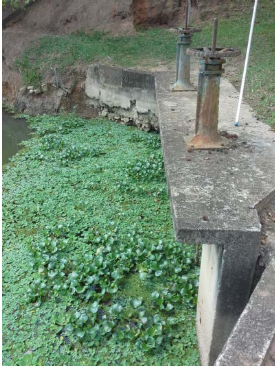
Descrição(1): Tomada de água
