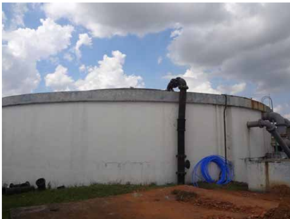
Figura 10 - Reservatório apoiado
