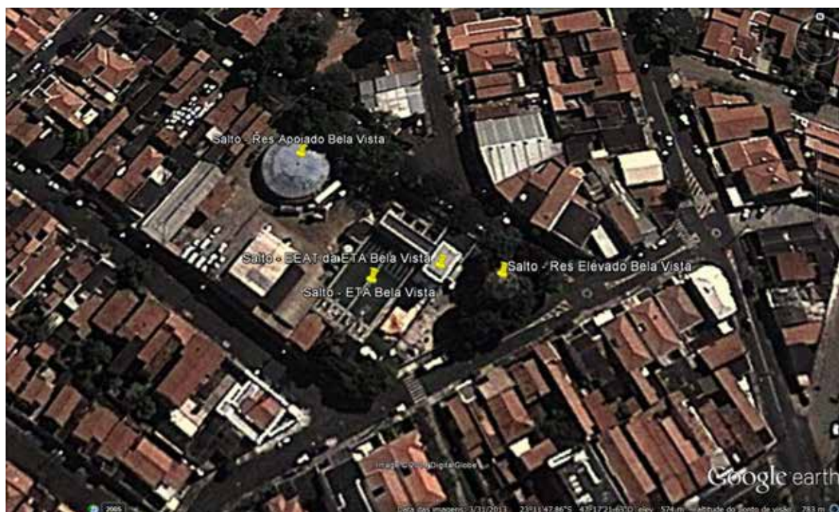
Figura 6 - Imagem de satélite da ETA e reservatórios
