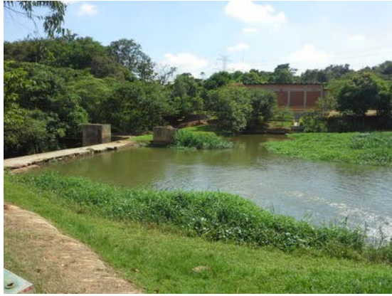
Descrição(2): Barramento e captação de Indaiatuba
