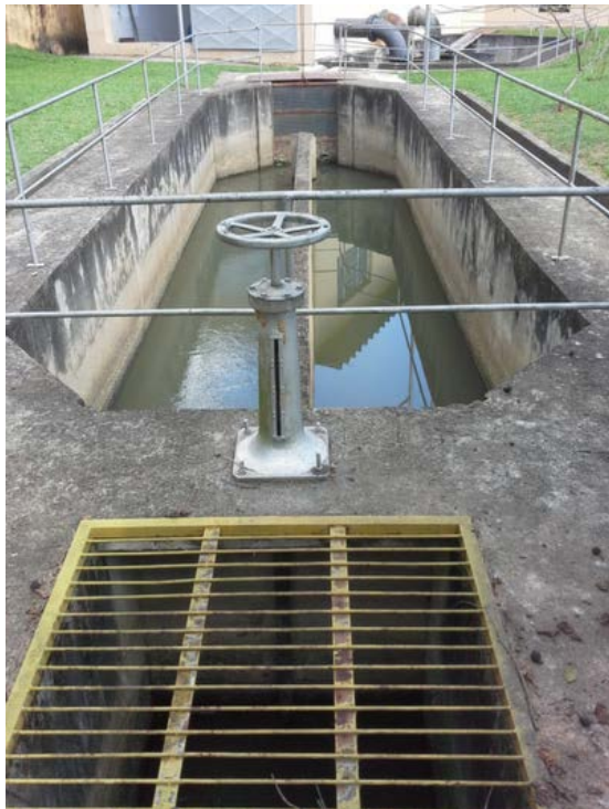
Descrição(2): Desarenador
