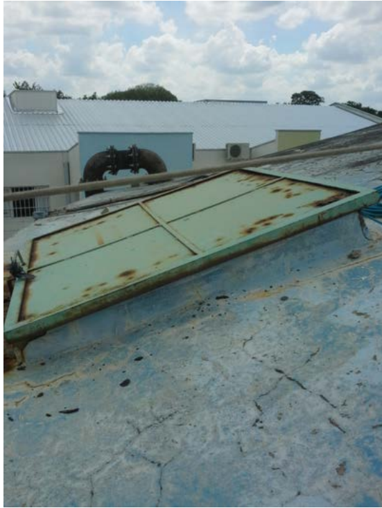
Descrição(3): Tampa de acesso e inspeção
