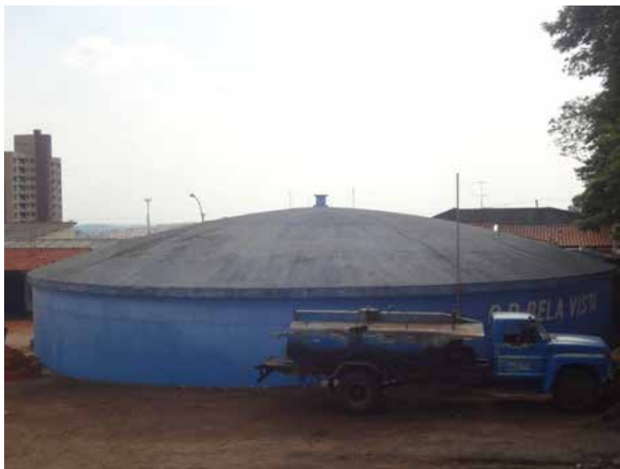
Figura 8 - Reservatório apoiado na ETA Bela Vista
