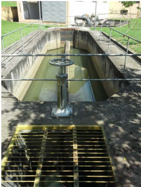
Descrição(5): Desarenador
