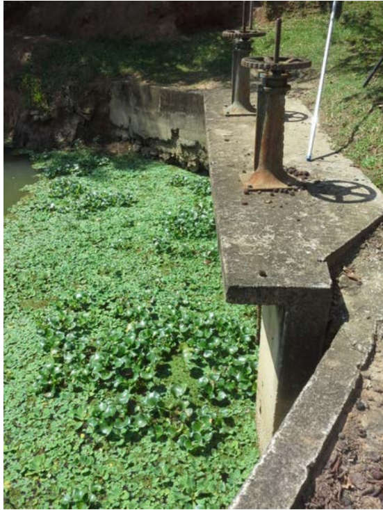
Descrição(4): Tomada de água
