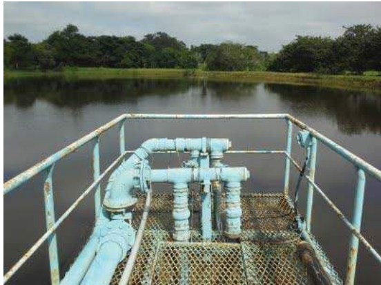
Descrição(4): Vista detalhada da captação superficial
