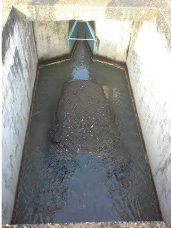
Descrição(2): Vista detalhada do desarenador
