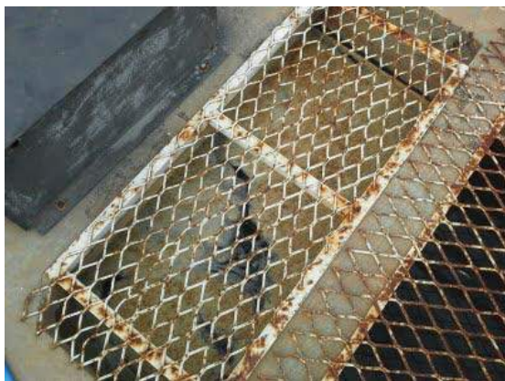
Descrição(5): Vista detalhada dos floculadores
