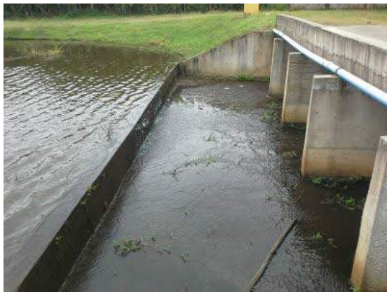
Descrição(4): Vista geral do vertedouro de superfície da barragem por gravidade
