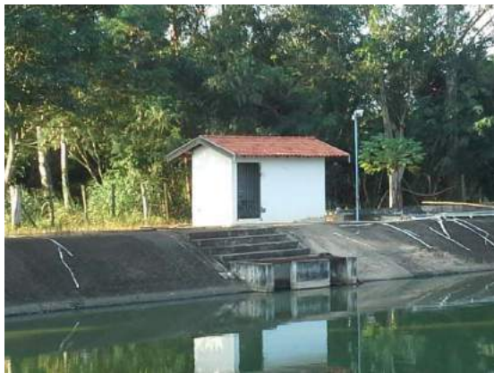
Descrição(8): Vista geral da casa do dosador de cloro e tanque de contato de desinfecção
