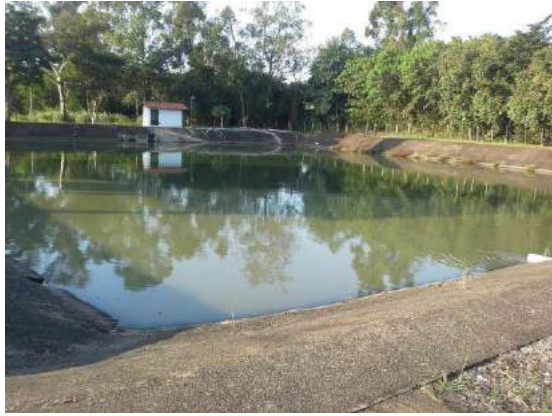
Descrição(4): Vista geral do tanque de decantação pós tanque de aeração
