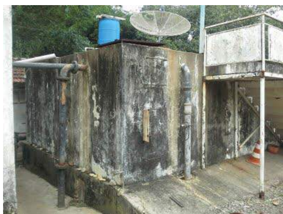
Descrição(5): Vista geral do reservatório
