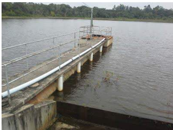
Descrição(5): Vista geral da captação superficial
