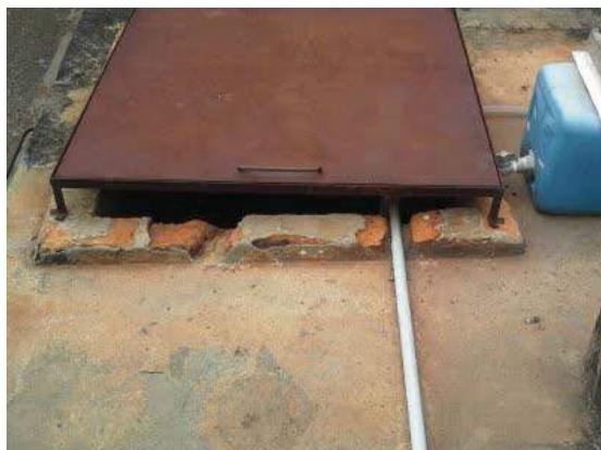
Descrição(3): Vista detalhada da tampa de inspeção
