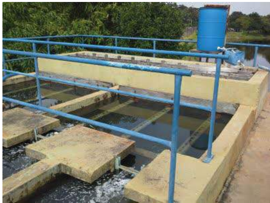
Descrição(5): Vista geral da ETA II
