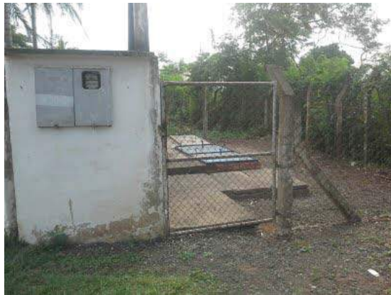
Descrição(4): Vista geral da elevatória
