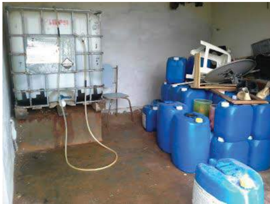
Descrição(6): Vista geral do armazenamento dos produtos químicos
