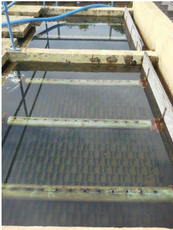
Descrição(3): Vista geral dos decantores
