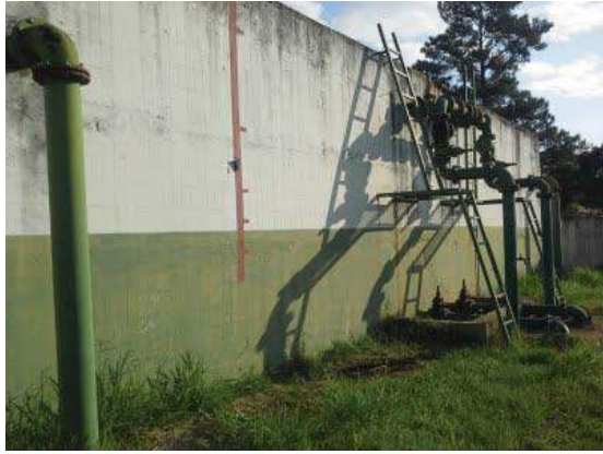
Descrição(2): Vista geral do reservatório
