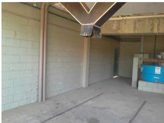
Descrição(6): Vista detalhada do carregamento do lodo pós centrífuga
