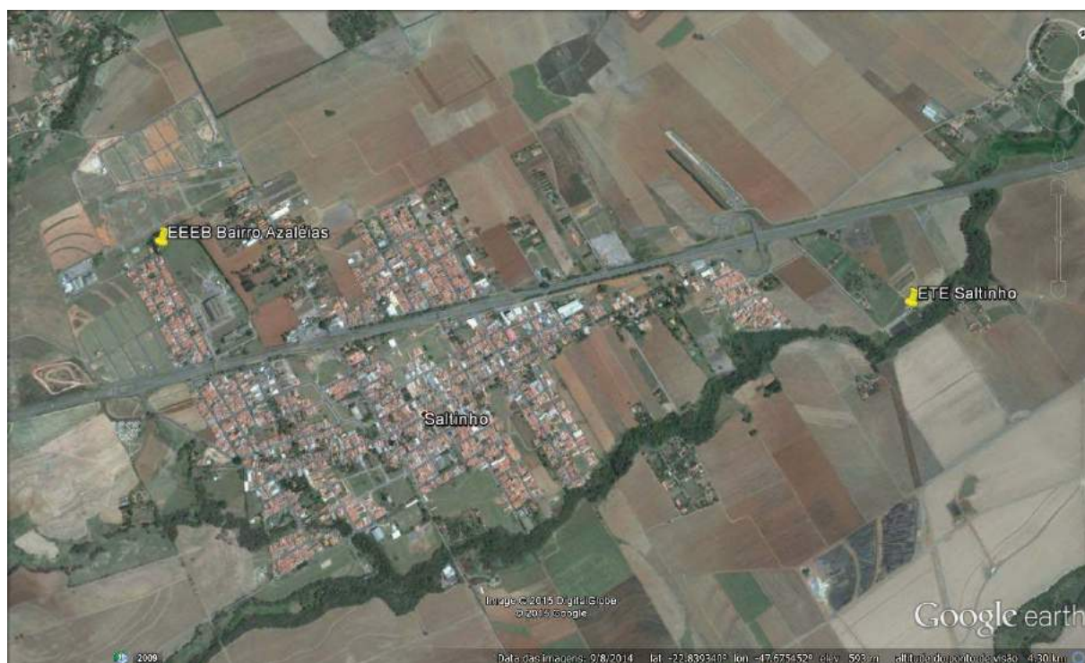
Figura 4 – Unidades fiscalizadas dos subsistemas de esgotamento sanitário, no município de Saltinho – SP
