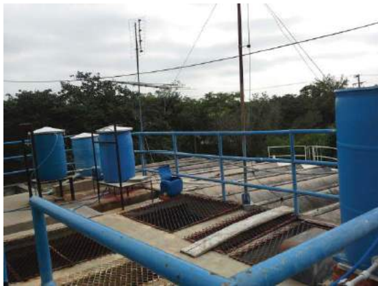
Descrição(7): Vista geral da ETA
