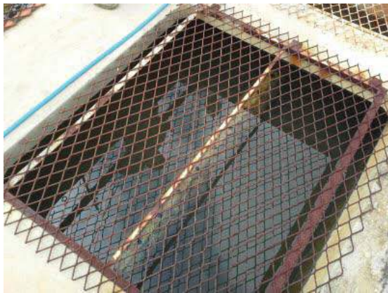
Descrição(4): Vista detalhada de um dos decantadores
