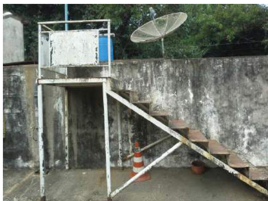
Descrição(4): Vista geral da escada de acesso à laje do reservatório
