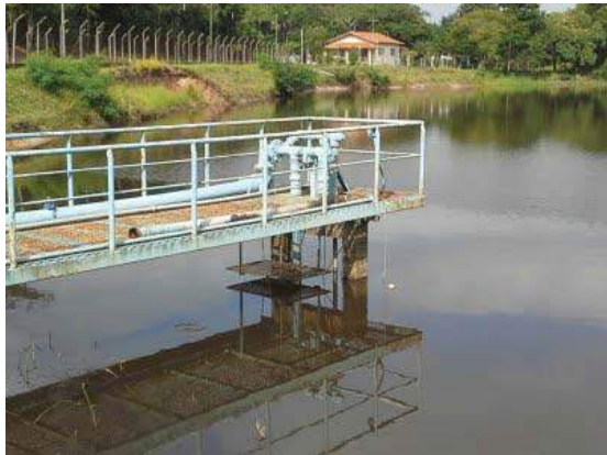
Descrição(5): Vista geral da captação superficial
