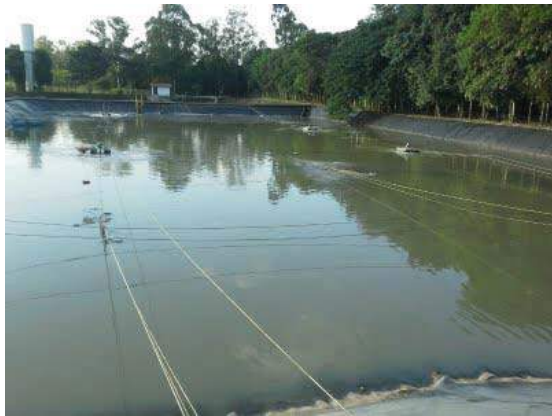
Descrição(3): Vista geral da lagoa de aeração
