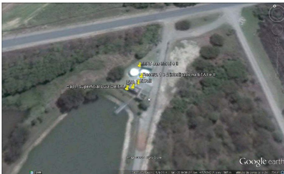
Figura 12 – Imagem de satélite da EEAT da ETA I e ETA II
