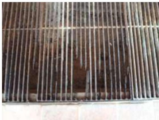
Figura 31 - Corrosão acelerada nos gradis do piso da saída de filtros
