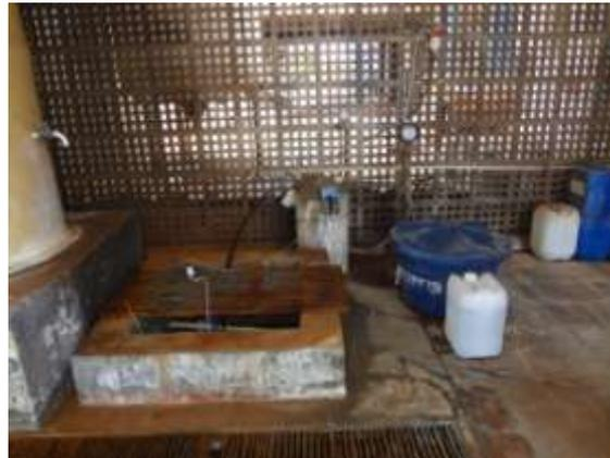
**Figura 25 - Sistema de dosagem de flúor e poliortofosfato**
