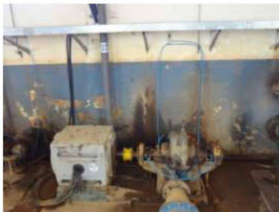
Figura 10 - Lubrificação de gaxetas e mancais com água tratada, devido a grande quantidade de areia na água bruta
