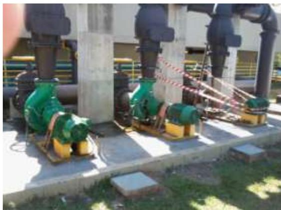
Figura 56 – Conjuntos de motobombas de recirculação de lodo
