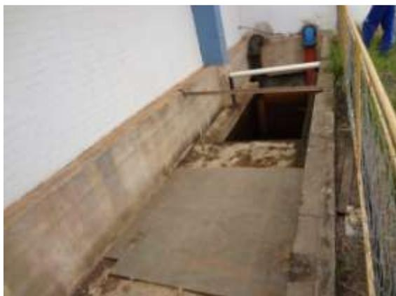
Figura 33 - Poço de sucção sem fechamento adequado
