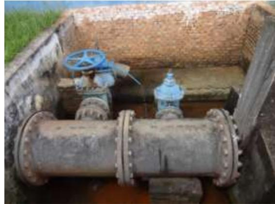
**Figura 6 - Vazamento em válvula antecipadora de ondas da Captação Nova**
