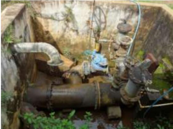
**Figura 5 - Vazamento em válvula antecipadora de ondas da Captação Velha**
