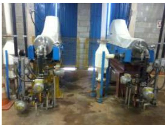
**Figura 54 - Sistema de desidratação de lodo**
