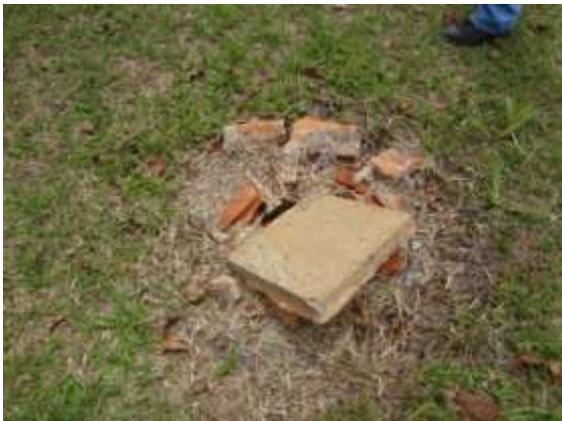
Figura 39 - Tampa de inspeção de reservatório (tanque de contato) inadequada, que permite a entrada de insetos, pequenos animais e resíduos.
