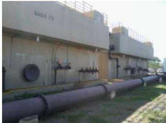
**Figura 50 - Detalhe descarte de lodo reatores aeróbios**
