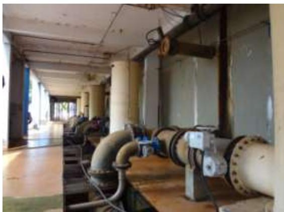
Figura 30 - Tubulações das saídas dos filtros rápidos
