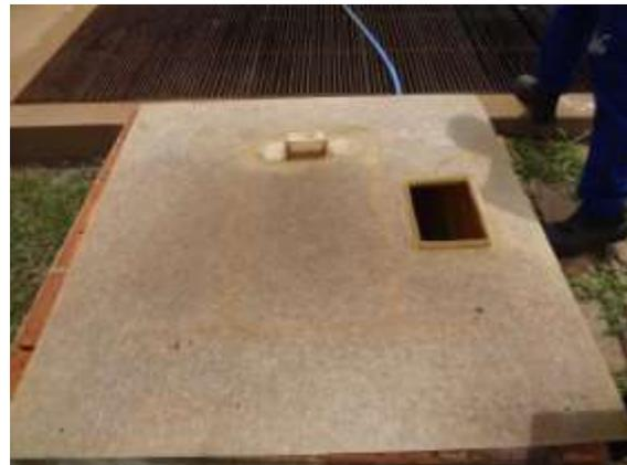
Figura 40 - Tampa de inspeção de reservatório (tanque de contato) sem fechamento adequado, que também permite a entrada de corpos estranhos.
