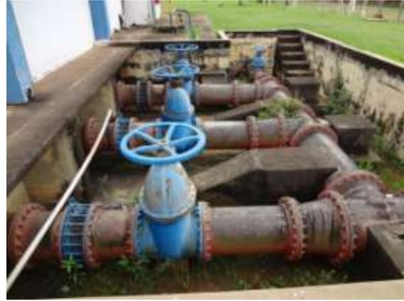
Figura 38 - Barrilete de saída do recalque
