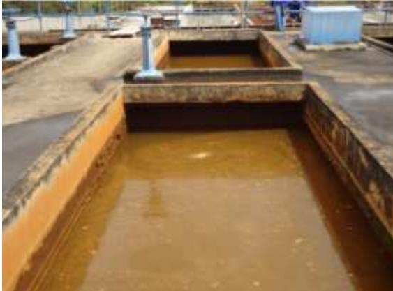
Figura 19 – Detalhe Floculadores e ponto de curto circuito
