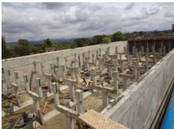
Figura 16 – Obras ampliação ETA II - Decantador
