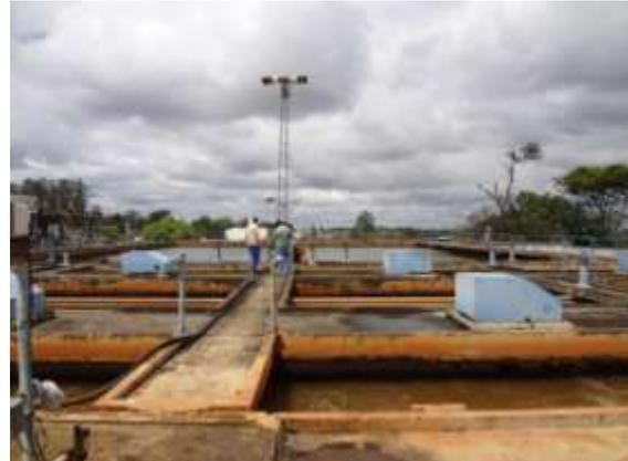
Figura 20 - Vista geral da ETA (falta de guarda-corpo)
