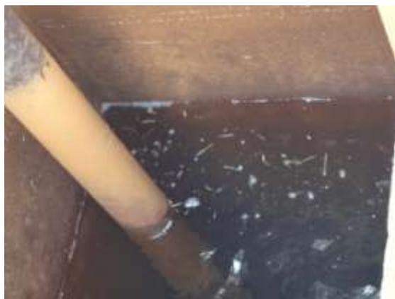
Figura 34 - Resíduos na água tratada (poço de sucção)
